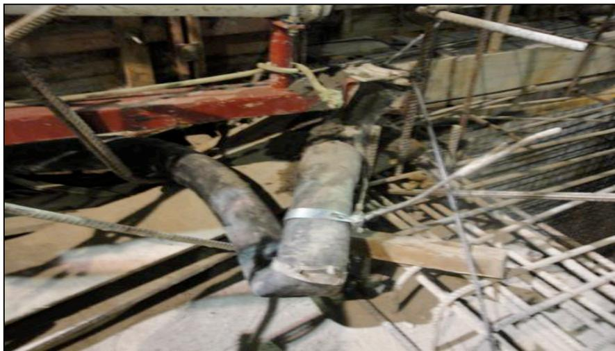
**Figura 18:** Mangote retorcido com queda da base da coluna.
