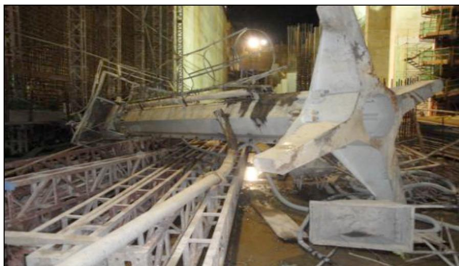
**Figura 19:** Torre de sustentação do braço lançador de concreto.
