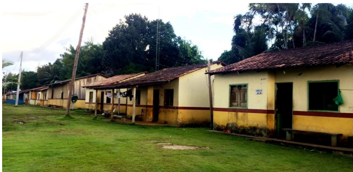
Figura 4: Imagens das casas construídas pelo governo federal na Comunidade de Itacoatiara Mirim, julho de 2018. Fonte: HEST.
