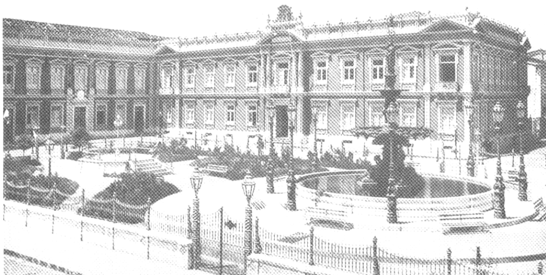
Fig 25 – Antigo Colégio dos Jesuítas, no Terreiro de Jesus, onde funcionava a Faculdade de Medicina e onde também ficou instalado, a partir de 1833, o Hospital de Caridade da Santa Casa, até 1893, quando foi inaugurado o Hospital Santa Isabel, em Nazaré. As aulas práticas da cadeira de Psiquiatria da Faculdade de Médica eram dadas no Asilo S. João de Deus, depois Hospital Juliano Moreira (Fonte: Bahia Illustrada , v.1, n.1, dez.1917).
