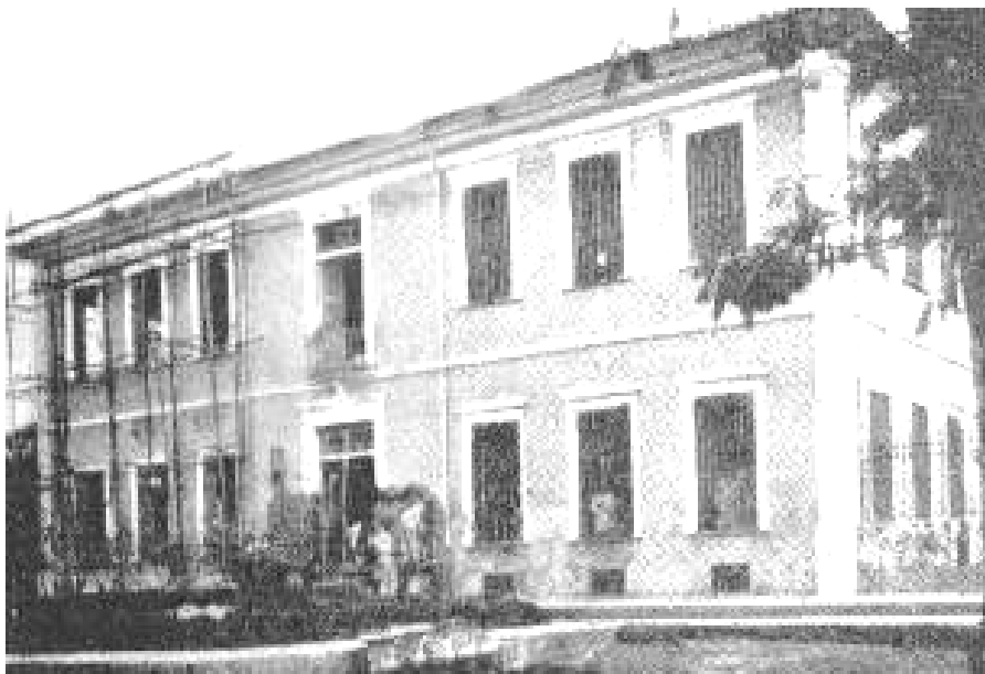
Fig 35 – Pavilhão Charcot (a legenda da ilustração aparece escrita com erro de grafia: “Cloreot” ), ainda em construção, em 1916, na gestão de Eutychio Leal. Antigo prédio do “Dormitório” ou “Enfermaria” de 1874 (Fonte: Bahia Illustrada , v.2, n.2, jan.1918).
