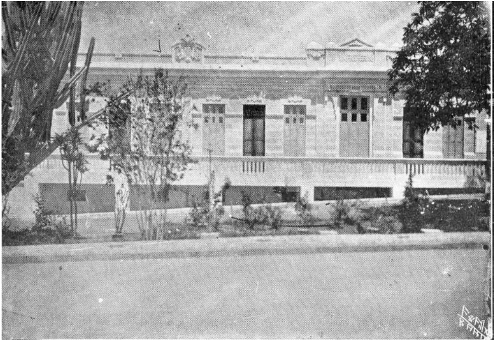
Fig 37 - Pavilhão de administração do Hospício S. João de Deus. Foto de 1919 (Fonte: Aragão, 1920).
