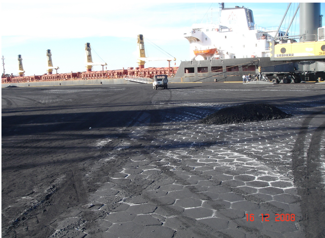
Figura 13 – Detalhe de piso sextavado na área do Cais 1. Porto de Suape, 16/12/2008. Foto: Santos (2008b).
