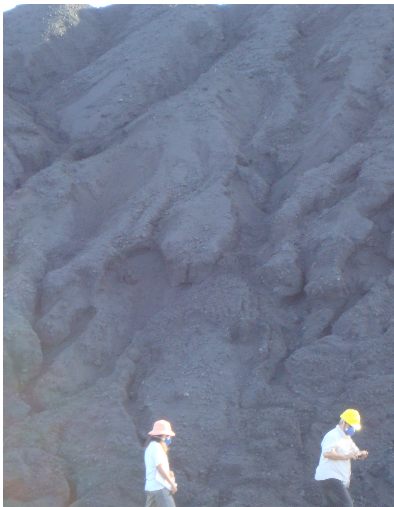
Figura 21 – Pilha de coque verde de petróleo de aproximadamente 9 metros de altura sofrendo efeitos da lixiviação.
