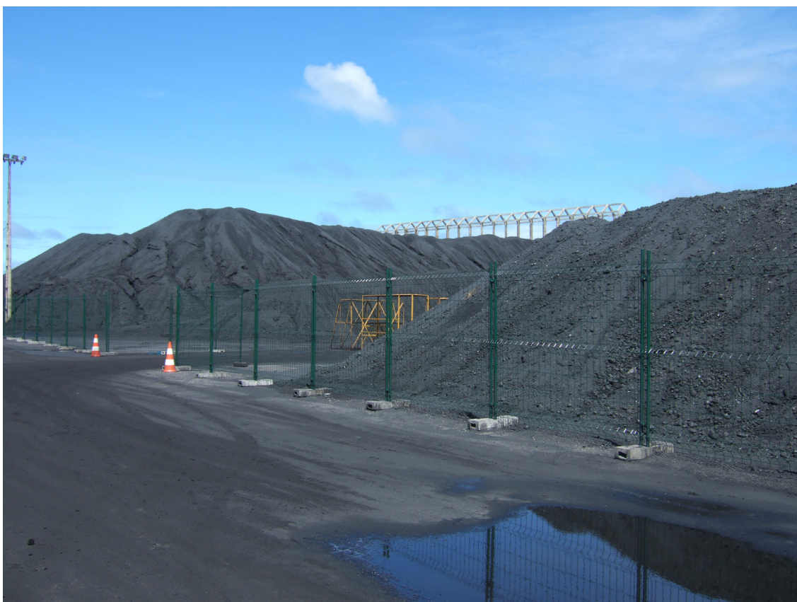
Figura 22 – Ausência de barreira de contenção de particulados e contaminação do solo pelo lixiviado e pela ação eólica. CIPS, 09/12/2008. Fonte: Gurgel (2008b).
