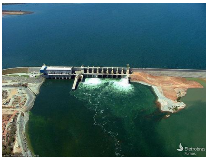
Figura 2: Foto aérea da barragem da usina hidrelétrica Peixe-Angical – TO, Brasil. Fonte: Eletrobrás - Furnas
