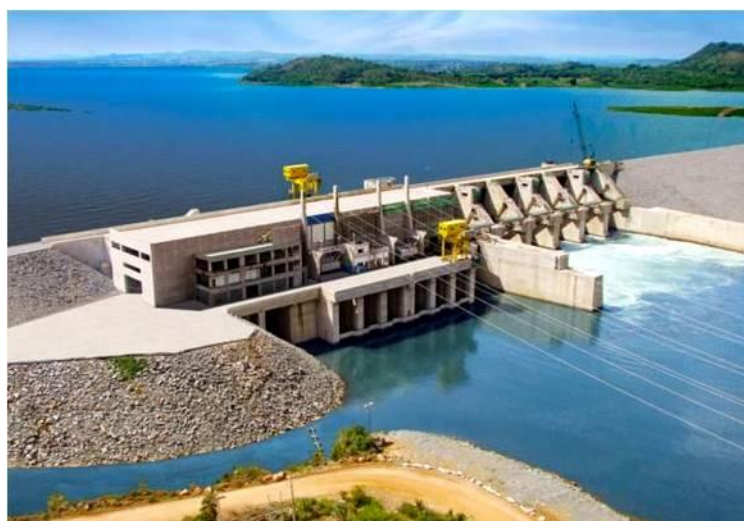
Figura 1. Barragem Usina Hidrelétrica São Salvador, localizada no município de São Salvador do Tocantins- TO.
