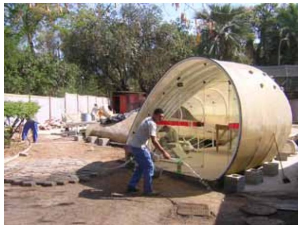
Drenagem e impermeabilização do Epidouro, 2011
