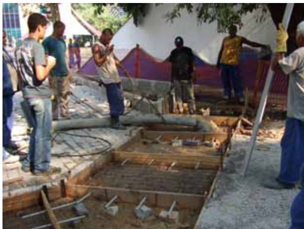
Recuperação dos revestimentos do auditório e do estacionamento do Museu da Vida, 2010
