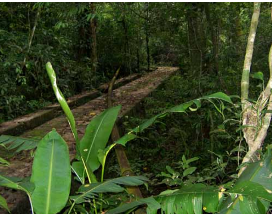
Trechos de superfície da canaleta, destacando-se as pedras lavradas que compõem as bordas de toda a sua extensão.
