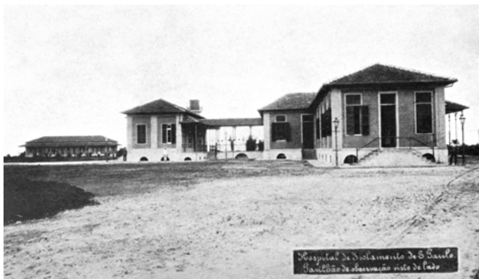
São Paulo Isolation Hospital. Observation Ward seen from the side ( Algumas instalações do Serviço Sanitário de São Paulo . São Paulo: Vanorden, 1905. Museu Emilio Ribas).
