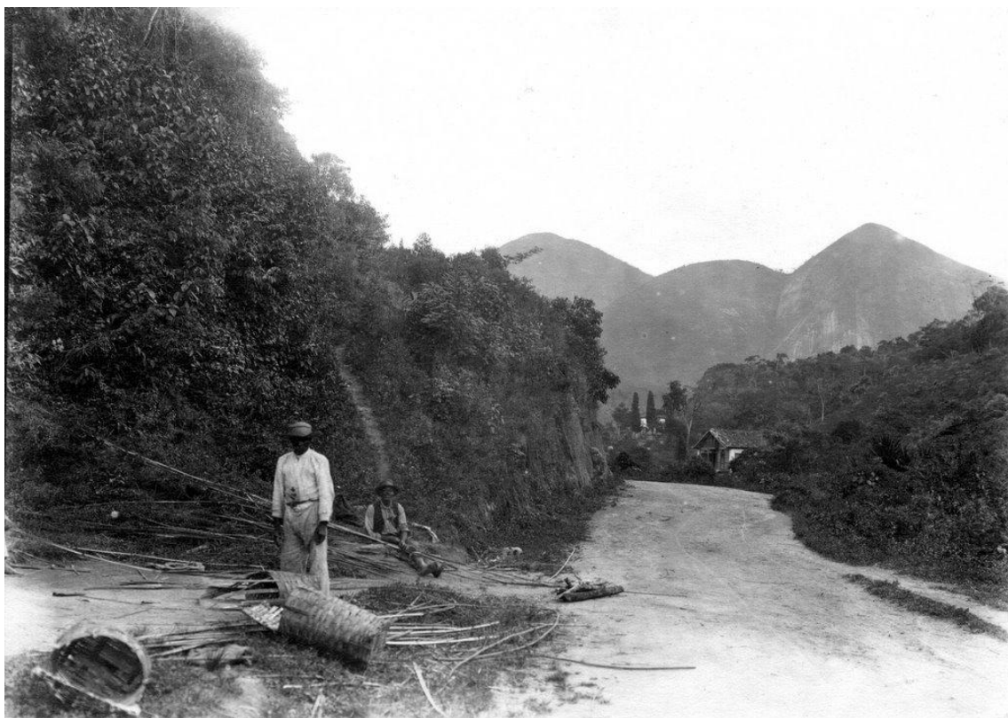
Figura 23 . Estrada para o Cônego. Fundação D. João VI de Nova Friburgo - 257
