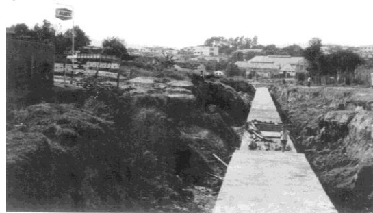
Figura 18: Canalização do córrego do Pastinho (Avenida Pedro II), em 1972 – Fonte: Fundação João Pinheiro, 1997a. (Acervo SUDECAP)
