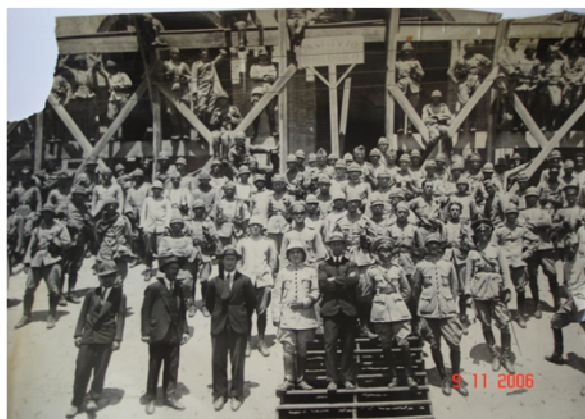
Figura 17: Oprédio em construção do Instituto Biológico, ocupado pelas tropas do governo em 1932 (Arquivo de Imagens – CMBSP)
