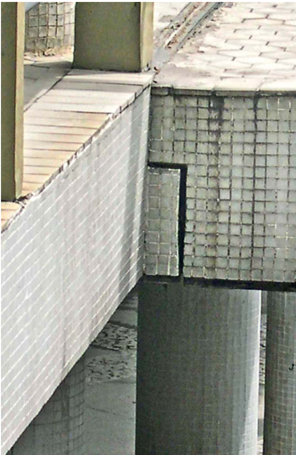
26 – Ligação entre os blocos feita por meio de dentes de apoio conhecidos como dentes Gerber – Connection between the blocks made with hinge-attached beams known as Gerber joint
