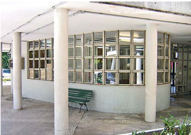
20 – Fechamento do foyer do auditório em esquadria de metal e vidro introduzido em intervenção realizada na década de 1990 – Enclosure of the auditorium foyer with metal window frames and glass installed during the alterations made during the 1990s
