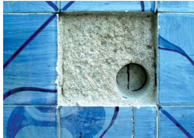
32 – Remoção de azulejo e argamassas para verificação de extensão de fissura – Removal of the tile and mortar to verify the extent of the crack
