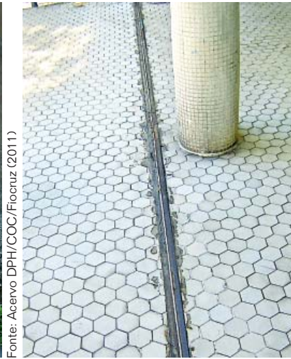
13 – Detalhe da junta de dilatação entre o bloco do auditório e o bloco retangular – The expansion joint between the auditorium and rectangular blocks
