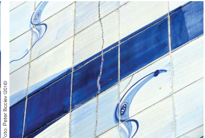
40 – Atividade biológica no corpo do azulejo, presença de microflora e perda de chacota e vidrado do azulejo – Biological activity in the body of the tile, presence of microflora and loss of the tile's bisque and glaze
