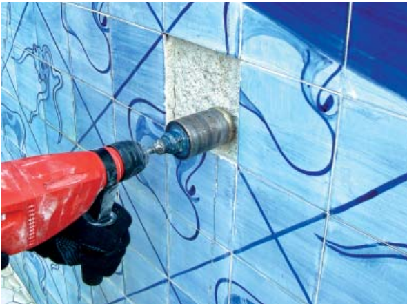
32 – Remoção de azulejo e argamassas para verificação de extensão de fissura – Removal of the tile and mortar to verify the extent of the crack
