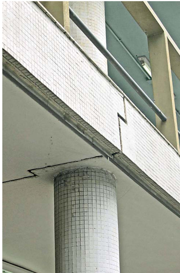
26 – Ligação entre os blocos feita por meio de dentes de apoio conhecidos como dentes Gerber – Connection between the blocks made with hinge-attached beams known as Gerber joint
