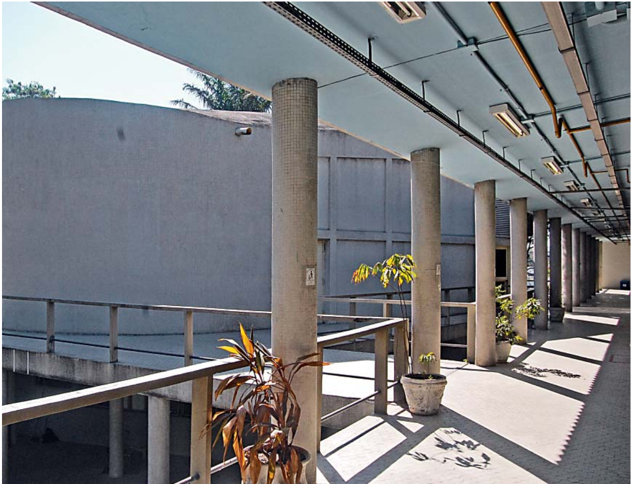
11 – Ao fundo, podem ser observadas as marcações dos antigos vãos na parede do auditório – At the bottom on the auditorium wall the marks of the original window frames are observable
