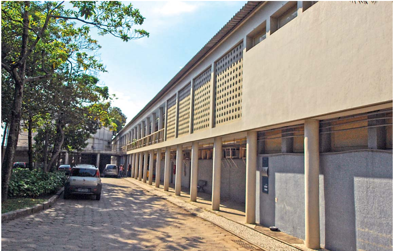
10 – Uso de cobogós como fechamento de parte dos vãos das varandas da fachada noroeste – Cobogós used to close off part of the veranda corridors of the northwest façade
