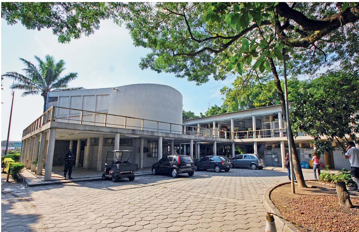
9 – Bloco do auditório com a marcação dos vãos das janelas no segundo pavimento, onde, originalmente, havia os brise-soleils – Auditorium block with the marks of the window spaces on the second floor, where the brise-soleils originally were
