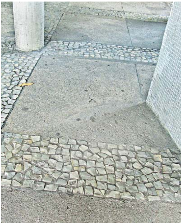
16 – Modificações realizadas na década de 1990: revestimento das colunas em pastilha cinza e pavimentação em pedra portuguesa e cimento – Renovations made in the 1990s: pillars clad with grey tiles and Portuguese stone and cement paving
