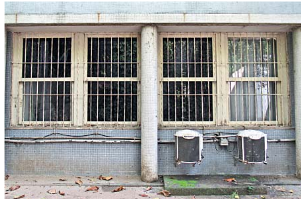
19 – Janelas tipo guilhotina em madeira, fachada sudeste, primeiro pavimento – Wooden sash windows – southeast façade, first floor
