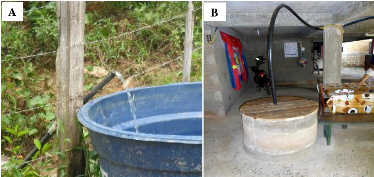
Figura 22. Mina d'água (A) e poço (B), Município de Laje do Muriaé, Rio de Janeiro, 2015.
