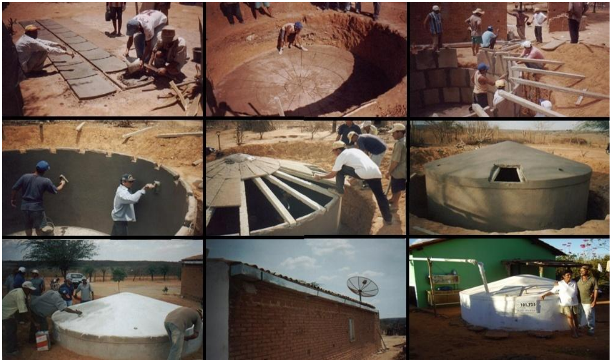
Figura 15. Etapas da construção da cisterna de placas (Fonte: Ministério do Desenvolvimento Social e Combate a Fome, 2011).
