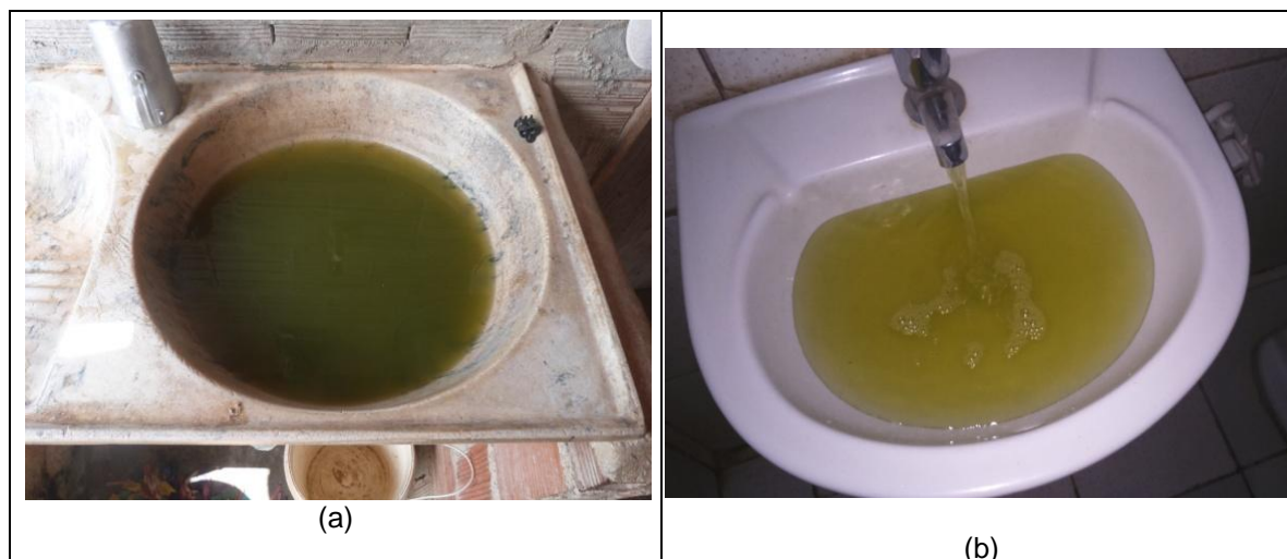
Figura 73. Aspecto das águas provenientes dos açudes de São Joaquim e Quieto quando chegam aos domicílios. (a) Pia em domicílio de São Joaquim Sede, proveniente do açude de São Joaquim, 2015 (b) Lavatório em domicílio de Quieto 2, do açude Quieto, 2015.
