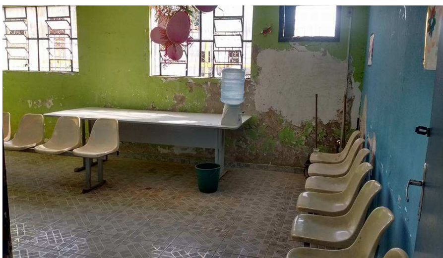
Fotografia 4 – Sala de espera (antigo refeitório)
