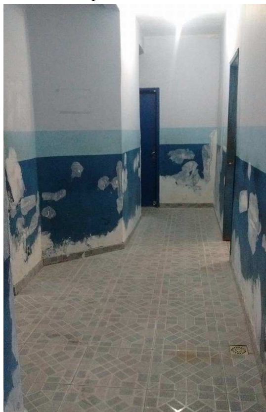
Fotografia 7 – corredor de acesso à cozinha, banheiro e dispensa de medicamentos.
