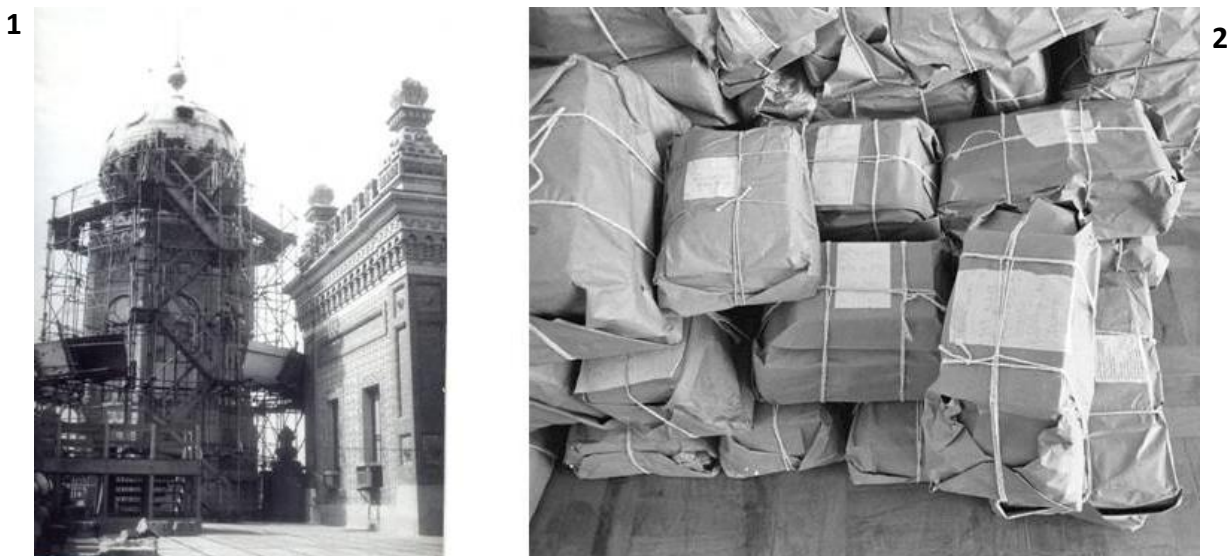
Figura 1 e 2: 1. Andaimos instalados na torre norte do Pavilhão Mourisco (Castelo da FIOCRUZ), em 1987. 2. Pacotes de livros depositados no Prédio da Expansão, em 6 de setembro de 1988. Fotos do Acervo DAD/Fundo COC.
