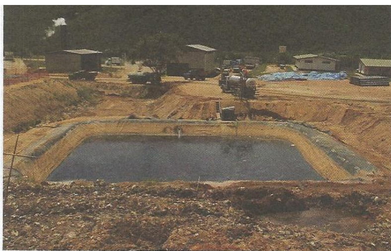
Figura 5: Piscina de coleta de chorume em um aterro sanitário de Nova Iguaçu – RJ em 2005 (p. 197, BIZZO; JORDÃO, 2009)
