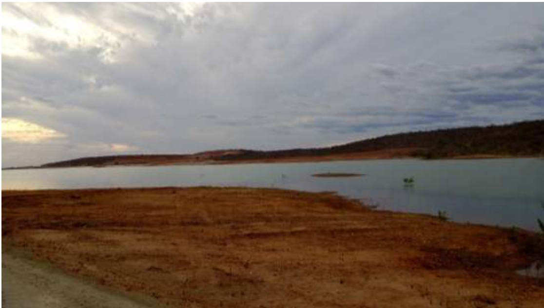
Fotografia 21 – Visão parcial da barragem construída na Aldeia Caraíbas, lugar antes ocupado pela Caatinga, povo Pipipã, Floresta/PE
