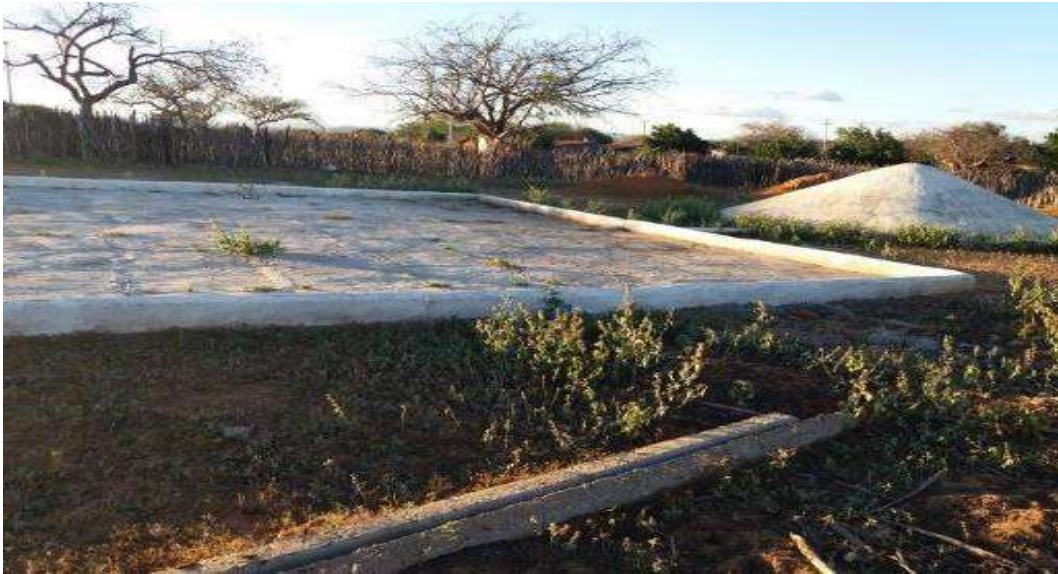
Fotografia 9 – Cisterna calçadão na Aldeia Travessão do Ouro, povo Pipipã, Floresta/PE
