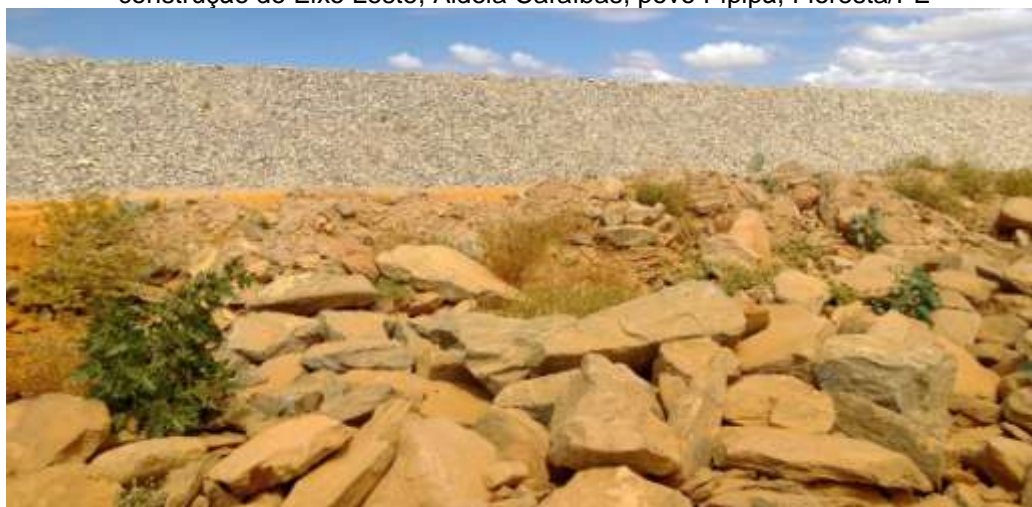
Fotografia 16 – Exploração das pedras do território para a produção de brita a ser usada na construção do Eixo Leste, Aldeia Caraíbas, povo Pipipã, Floresta/PE
