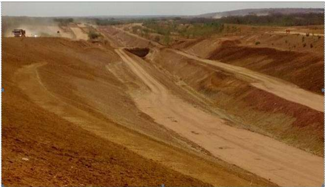
Fotografia 14 – Escavações para construção do Eixo Leste da transposição do rio São Francisco, na Aldeia Caraíbas, simbolizando o “estupro do território” Pipipã, em Floresta/PE, 2014
