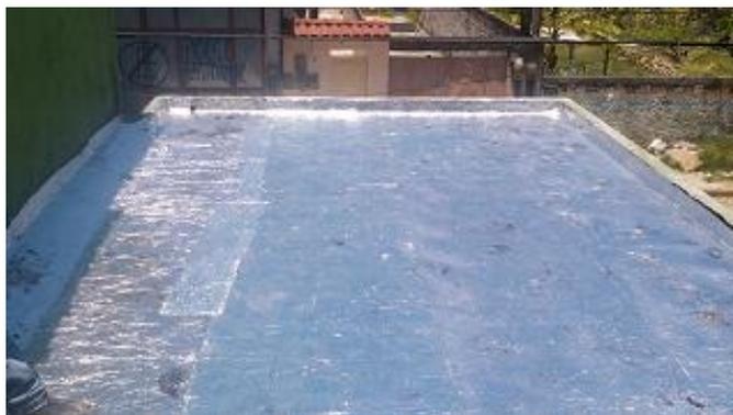
**Figura 4** – Impermeabilização da laje do IVR.
