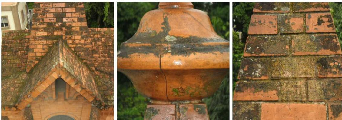
*Figura 29: Colonização biológica (líquens) e crostas negra (sujidades) na superfície externa de tijolos e ornatos do telhado. Fonte: Autor, 2018.*
