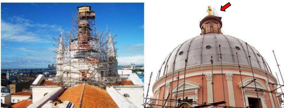
*Figura 10: Instalação de escada metálica de acesso ao topo da cúpula. Fonte:*
