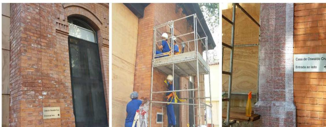
*Figura 38: Tratamento de eflorescências de sais na superfície dos tijolos do revestimento externo da Fachada. Fonte: Arquivo DPH, 2017.*
