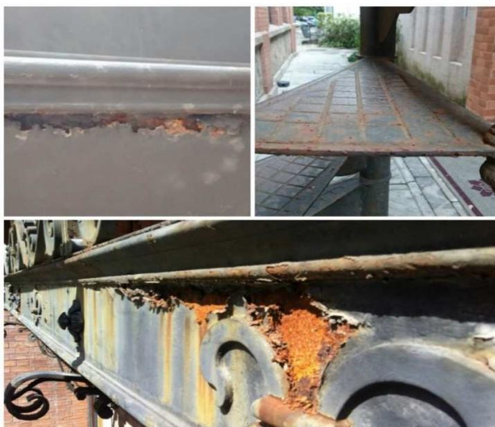
*Figura 34: Chapa de acabamento inferior da calha e escada externa em processo de corrosão do ferro.
