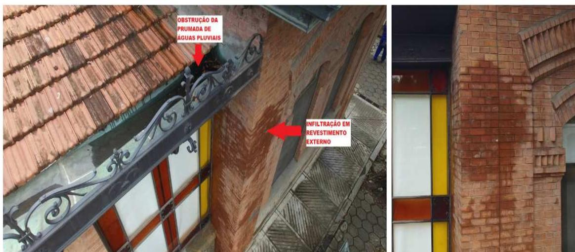
*Figura 37: Entupimento do sistema de águas pluviais e infiltração, março de 2017- Pavilhão do Relógio. Fonte: Drone - Arquivo DPH, 2017.*
