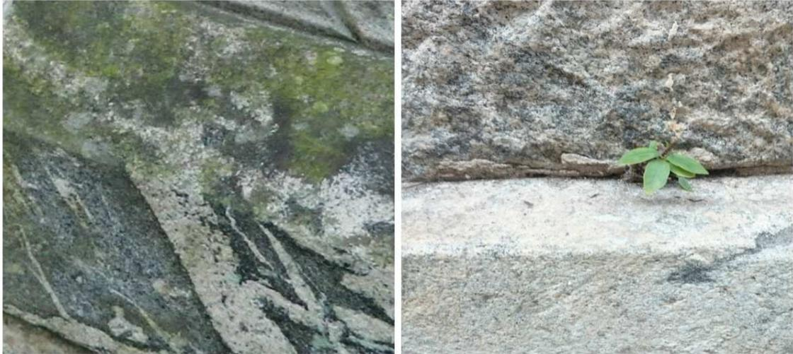
*Figura 32: Colonização biológica (líquenes) e crescimento de vegetação (vegetação parasitária) no embasamento de granito. Fonte: Autor, 2018.*
