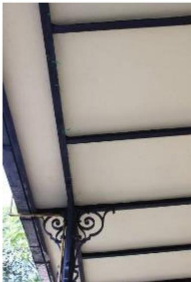
Figura 112: Tubulação instalada acompanhando a calha e o pilar metálico.
