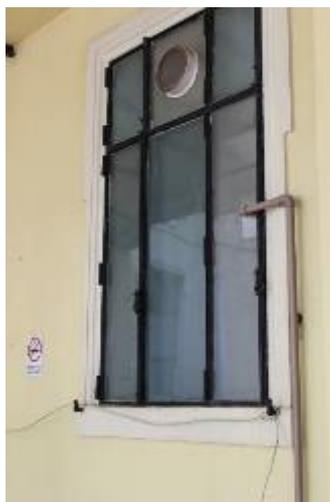
Figura 107: Tubulação e fiação nas esquadrias
