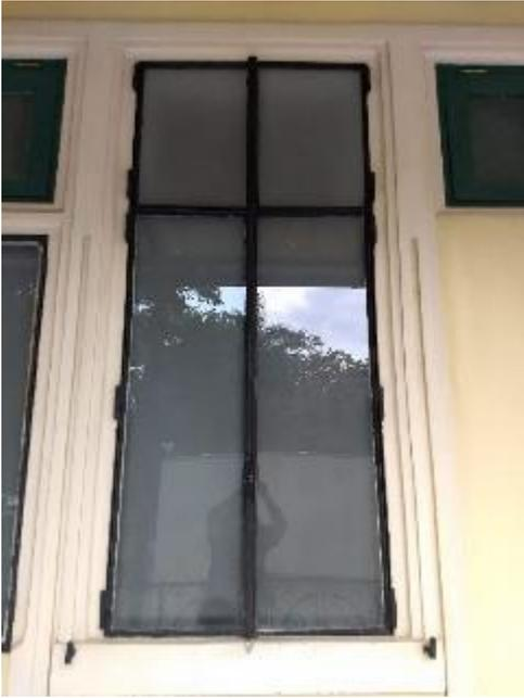
Figura 12: Esquadria original em ferro fundido (DPH/COC).
