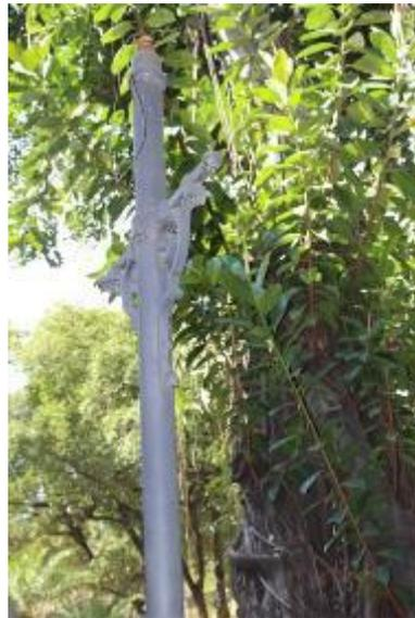
Figura 36: Ausência do globo de vidro original com perda do bocal.
