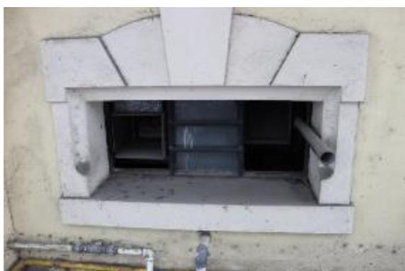
Figura 120: Tubulações instaladas sobre a manta e nas janelas
