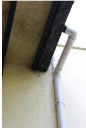
Figura 70: Tubulações das águas pluvias – sem consulta ao DPH
