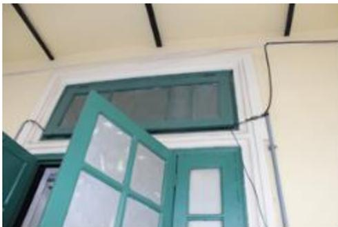
Figura 58: Passagem de cabos pela bandeira da porta com instalação de tubulação na fachada – DPH não foi consultado.
