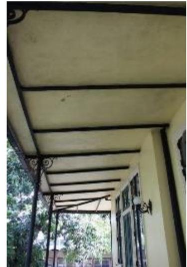
Figura 71: Teto da laje da varanda – escurecida devido a umidade superior.
