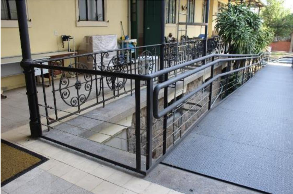
Figura 27: Situação atual da rampa de acesso a varanda do segundo pavimento sem os gradis originais - 2018 (DPH/COC)
