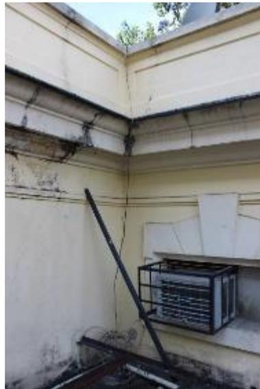
Figura 83: Suportes sem uso, cabos soltos, alteração da esquadria original.
