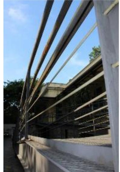
Figura 94: Rampa instalada – Ausência de ações de manutenção
