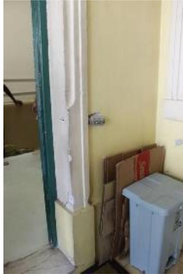
Figura 44: Interruptor solto e uso inadequado dos espaços
