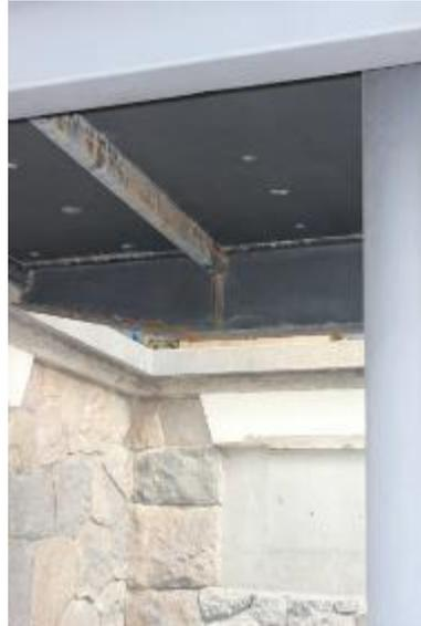
Figura 93: Rampa instalada – Ausência de ações de manutenção
