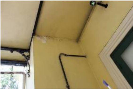
Figura 41: Estufamento da pintura – Umidade vindo da laje
