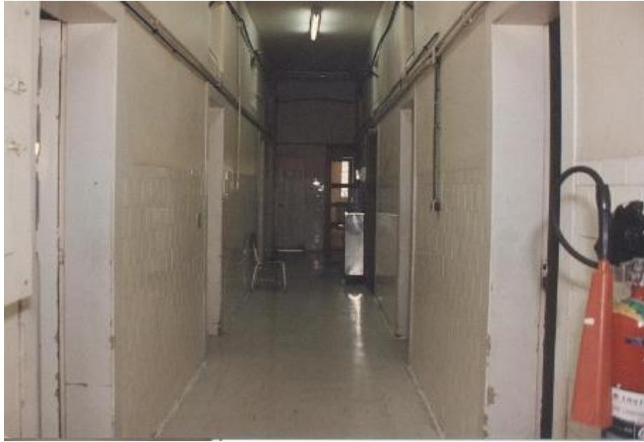
Figura 21: Alvenarias espessas cobertas de azulejos e piso originais na área das enfermarias – final da década de 1980 (DPH/COC)
