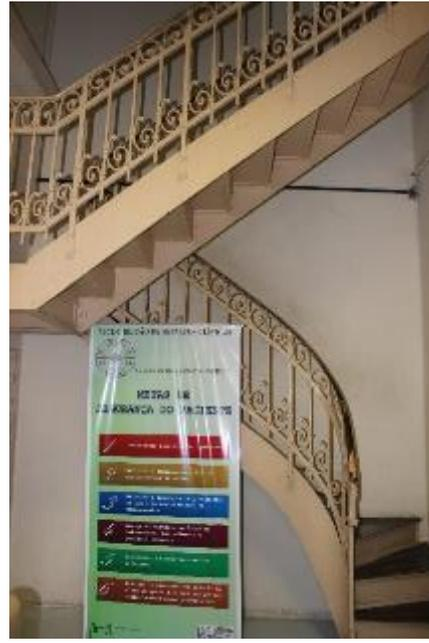
Figura 13: Escada interna em ferro fundido (DPH/COC).
