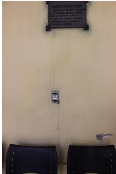
Figura 47: Limpeza da placa, perda de acabamento de elétrica e reboco
