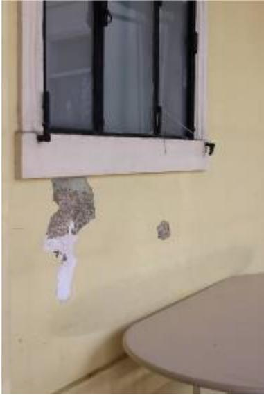
Figura 38: Perda de reboco e utilização de cordas nas esquadrias.
