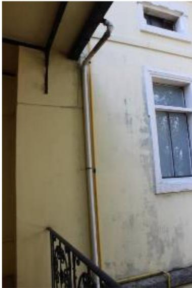
Figura 46: Tubulação de gás e de águas pluviais
