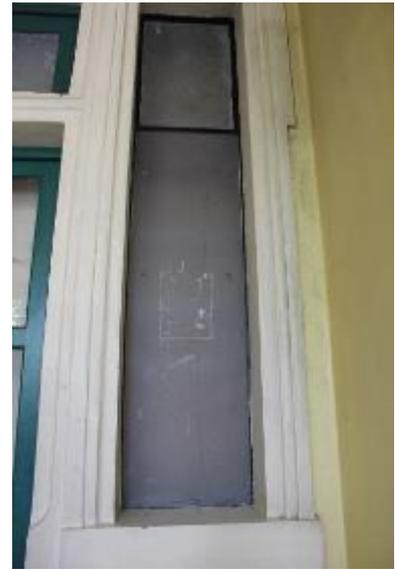
Figura 48: Vidros sujos e com aplicação antiga de adesivos.
