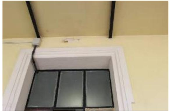
Figura 42: Instalação de infra com furação no vidro.
