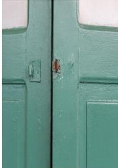
Figura 61: Fecho quebrado da porta (Detalhe figura 54)
