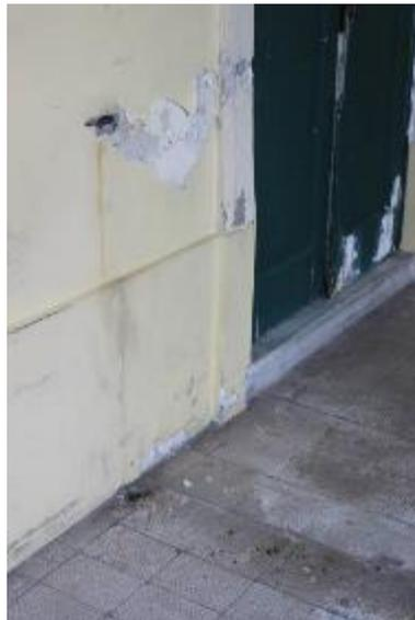
Figura 64: Piso com resquícios de tinta. Perda de reboco. Problemas na porta.
