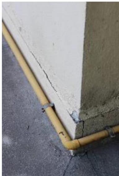
Figura 116: Braçadeiras metálicas fixadas na alvenaria sobre a manta.
