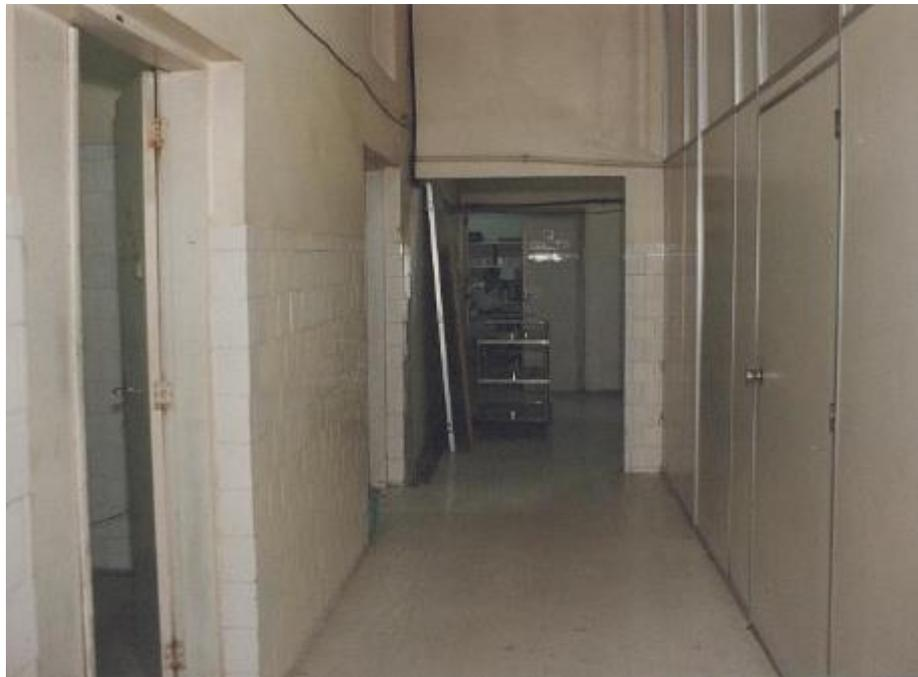
Figura 22: Alvenarias espessas cobertas de azulejos e piso originais na área das enfermarias – final da década de 1980 (DPH/COC)
