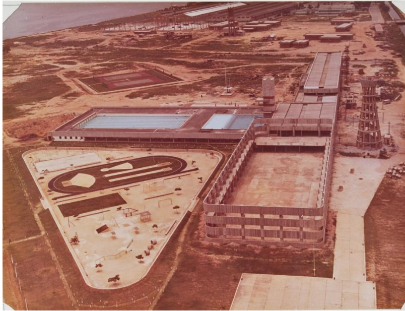
Figura 7: primeira fase das obras no CEFAN. Fonte: Acervo Histórico do CEFAN.
