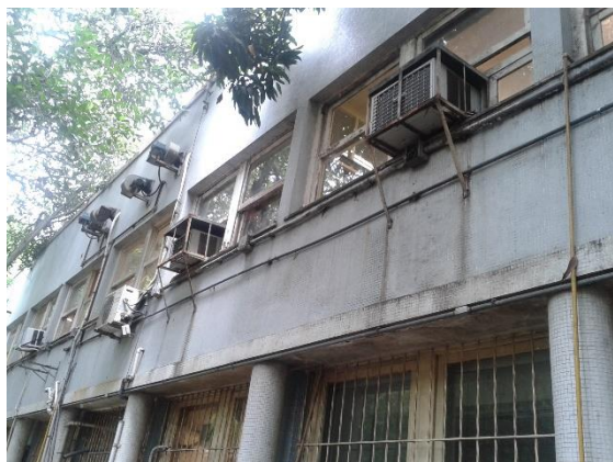
Figura 38 Pavilhão Arthur Neiva: instalações aparentes percorrendo a fachada sudeste, 2018. Foto: Rosana Zouain.
