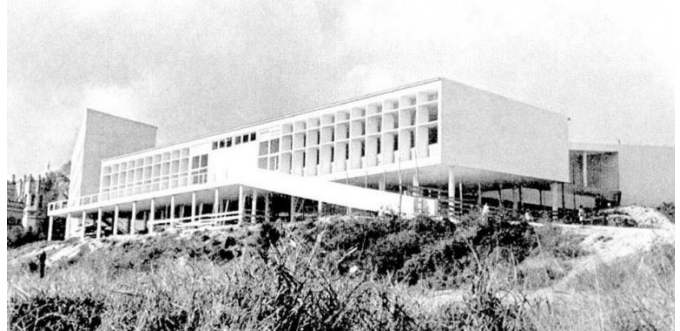
Figura 29 Restaurante Central na década de 1950. Fonte: Arquitetura Moderna no Brasil (Mindlin, 2000)
