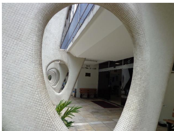
Figura 84 Laboratório da Febre Amarela: inserção de rebaixo sob a laje em balanço em frente à entrada principal, 2015. Fonte: DPH/COC
