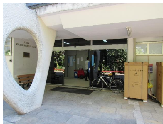
Figura 85 Laboratório da Febre Amarela: substituição da esquadria original da entrada principal e uso inapropriado do espaço coberto da laje em balanço, 2017. Foto: Rosana Zouain
