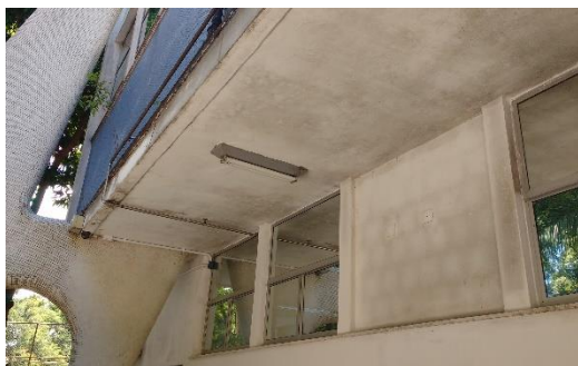
Figura 86 Laboratório da Febre Amarela: vedação de vão na fachada sul, introdução de luminária sob a laje e tubulações aparentes percorrendo a fachada sul, 2016. Foto: Rosana Zouain..
