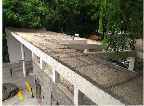
Figura 53 Portaria Av. Brasil: cobertura vista a partir da passarela provisória para travessia de pedestres na Av. Brasil, 2018. Foto: Rosana Zouain.
