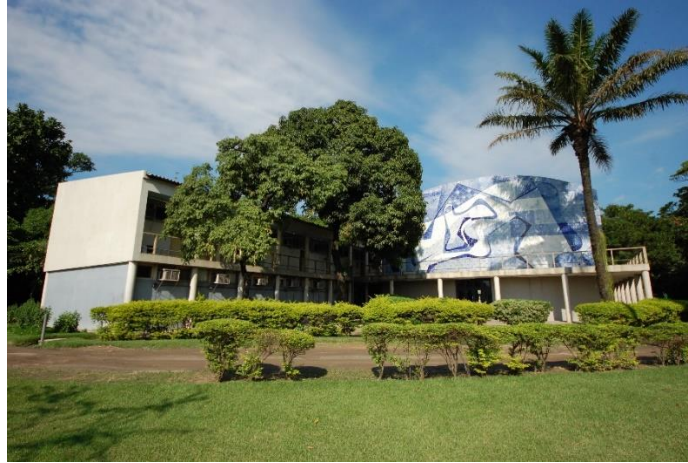
Figura 31 Pavilhão Arthur Neiva: vista a partir da Avenida Brasil, 2016. Fonte : DPH/COC/Fiocruz.
