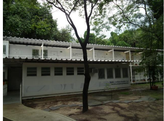
Figura 37 Pavilhão Arthur Neiva: módulos provisórios para ampliação da área de ensino do IOC, 2016. Fonte: DPH/COC
