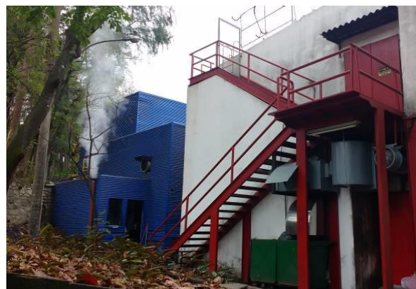
Figura 81 Laboratório da Febre Amarela: fachada lateral e anexo, 2016. Foto: Rosana Zouain
