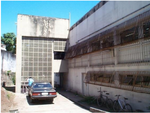
Figura 46 Pav. Carlos Augusto da Silva: castelo d'água demolido na obra de 2004, data foto. Fonte : Acervo DPH/COC.
