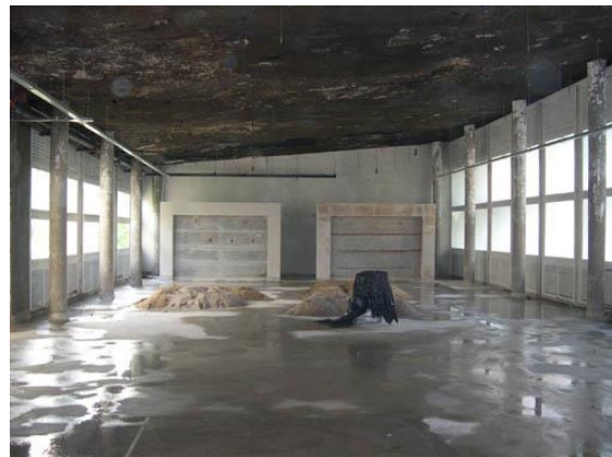
Figura 49 Pav. Carlos Augusto da Silva: salão após a obra de 2004. Ao fundo as paredes construídas para abrigar os equipamentos do sistema de climatização. Fonte: DPH/COC/Fiocruz
