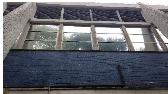
Figura 87 Laboratório da Febre Amarela: substituição dos vidros translúcidos por vidros reflexivos na fachada sul, 2016 Foto: Rosana Zouain.
