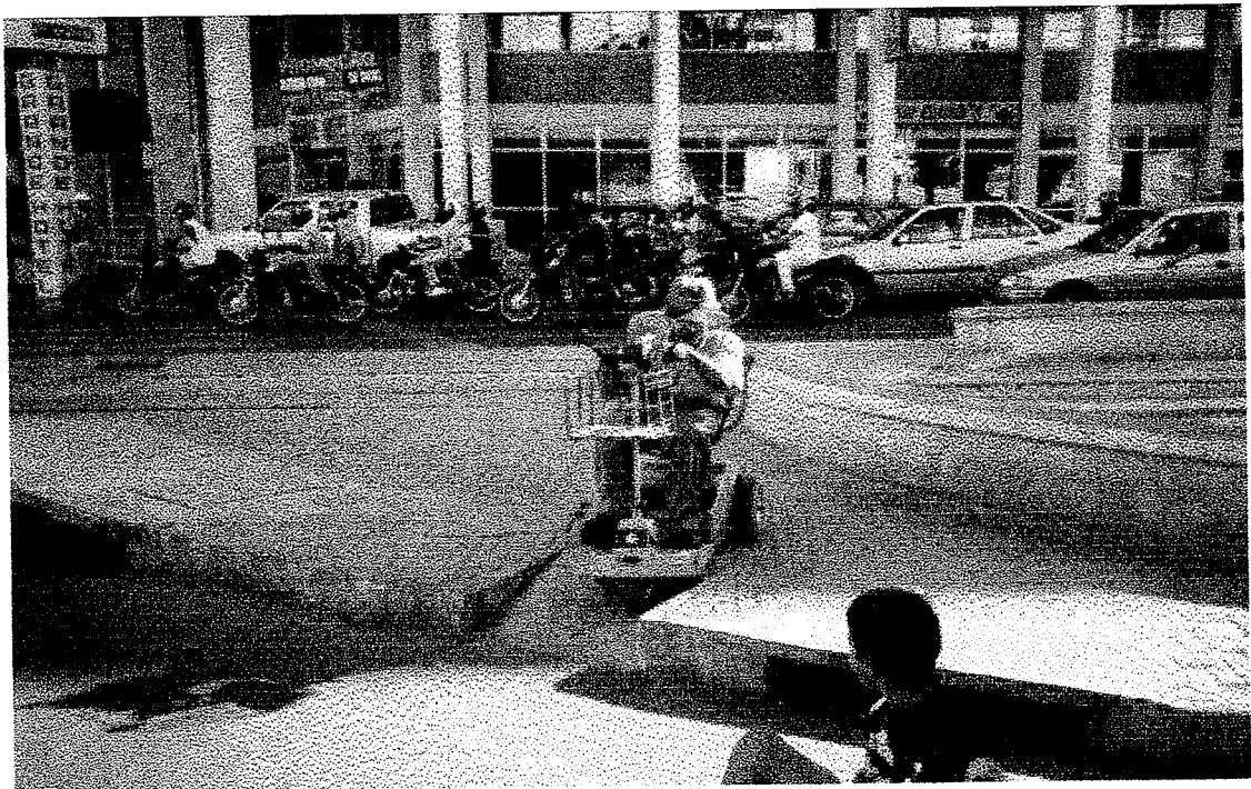
Foto 8 – Rampa com dimensão inadequada
