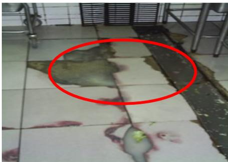
Foto 6. Piso com rachaduras e poça de água.
