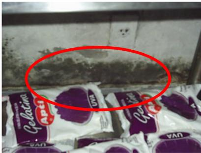
Foto 4. Parede do estoque apresentando infiltração.
