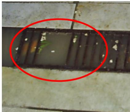
Foto 8. Canaleta sem tela de proteção e com entupimento
