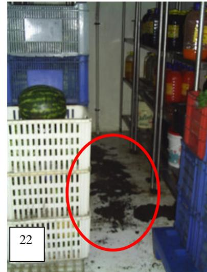
Fotos 20, 21 e 22. Não conformidades encontradas nas câmaras frigoríficas: acabamento da porta, parede e piso em péssimo estado de conservação.
