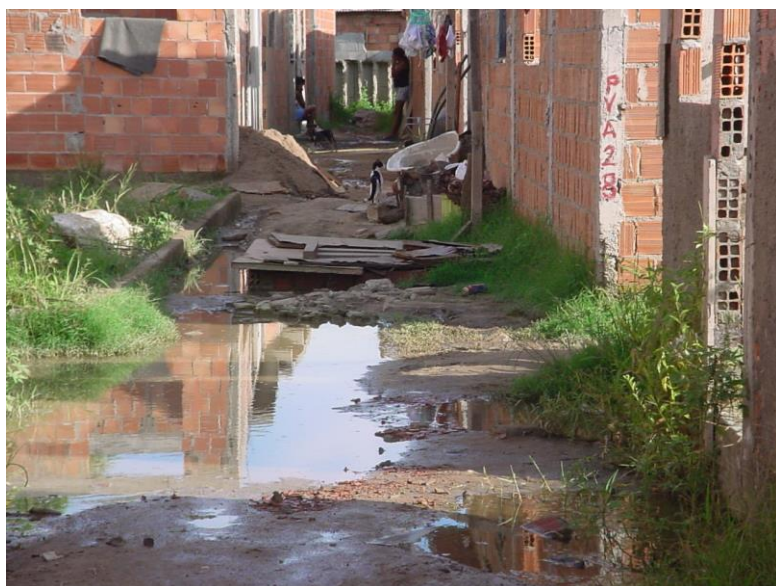
Figura 23 - Problemas de drenagem em comunidade de Manguinhos.
