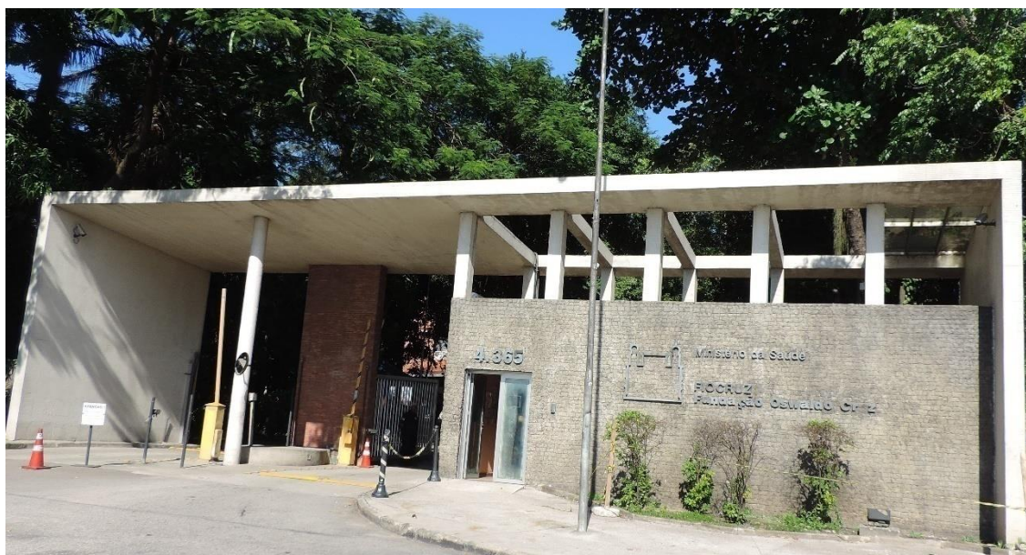
Figura 8: Portaria da Avenida Brasil.
