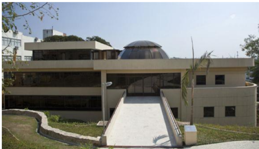
Imagem 6: Prédio Anexo ao edifício sede do MAST
