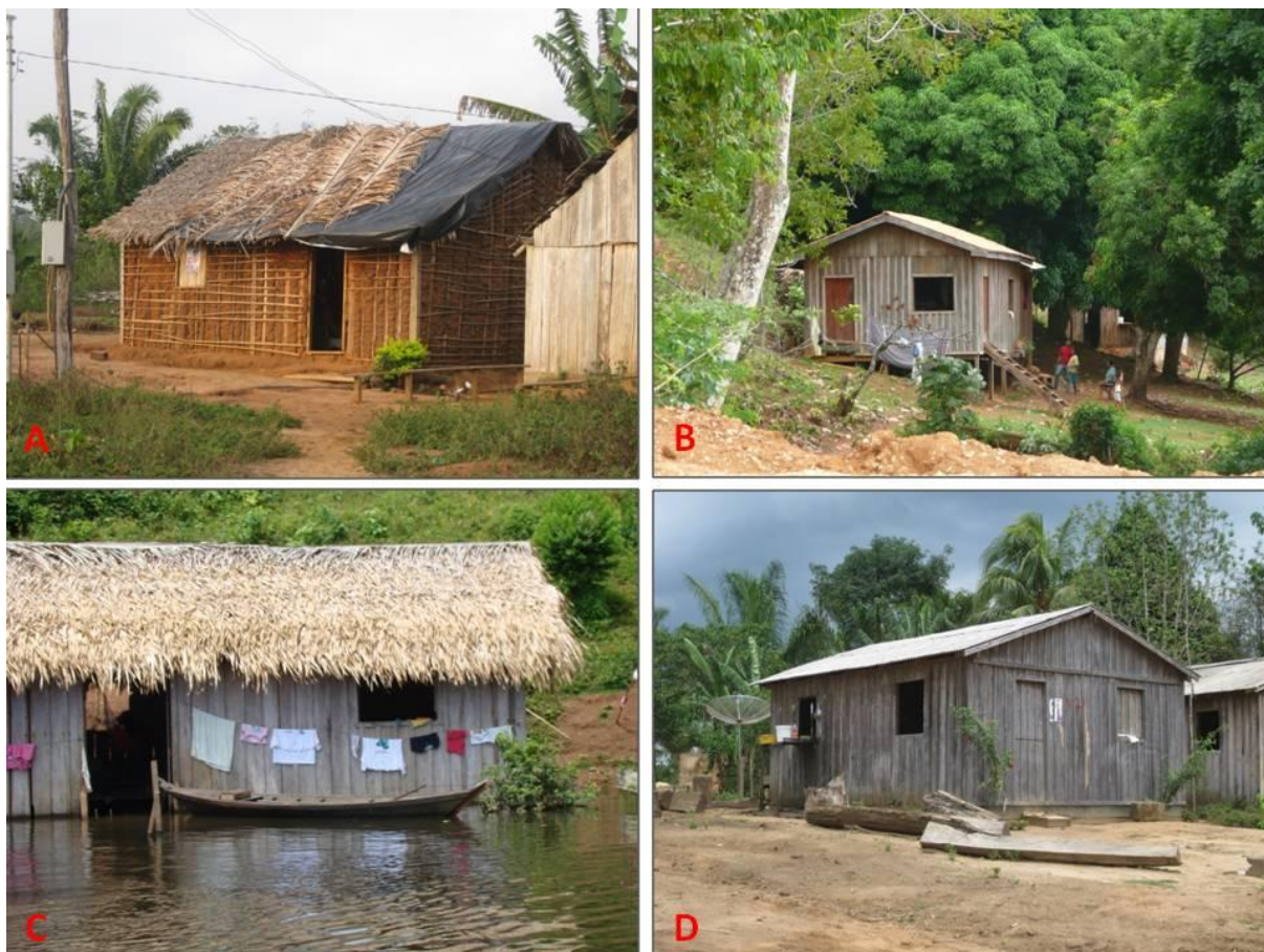
Figura 3: Casas típicas das áreas de estudo: (A) casa de pau-a-pique com telhado de lona e folhas de palmeiras; (B) casa de madeira construída sobre palafitas e teto com telhas de amianto; (C) casa ribeirinha construída de madeira com telhado de palha; (D) casas de madeira com telhado de amianto.
