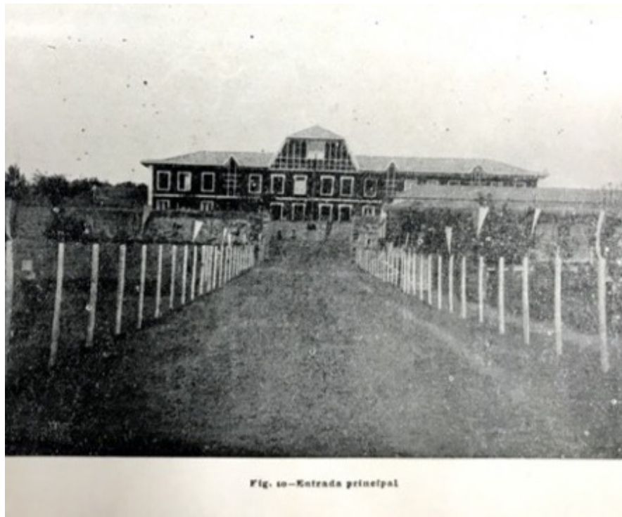
Figura 3.24 - Vista geral do edifício central após a remodelação de 1921.
