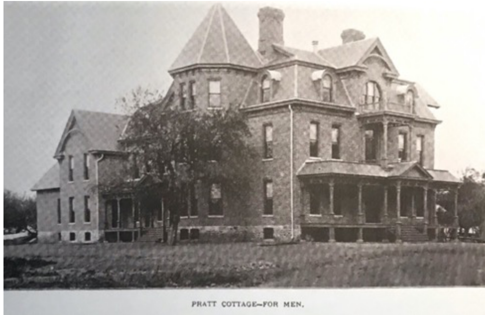
Figura 4.17 - Vista do Pratt Cottage.
