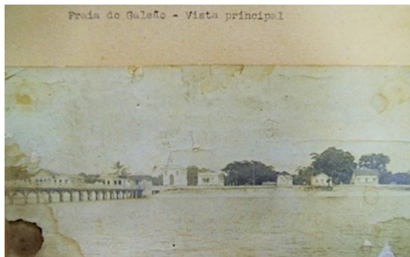
Figura 3.11 - Vista da Ponta do Galeão; ao fundo, a Colônia Conde de Mesquita.
