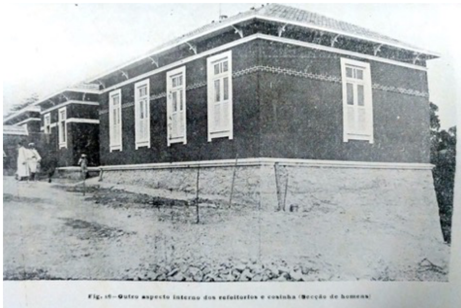
Figura 3.28 - Fachada lateral – refeitório e cozinha; seção masculina.
