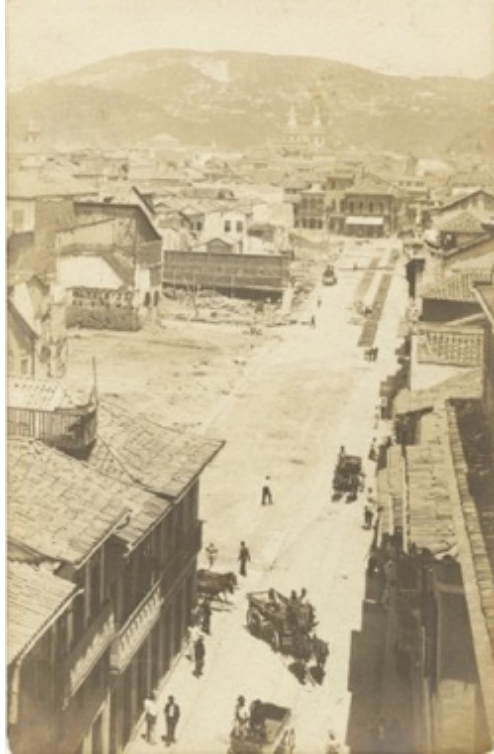
Figura 2.6 - Fotografia aérea das demolições na Rua do Sacramento depois do prolongamento.
