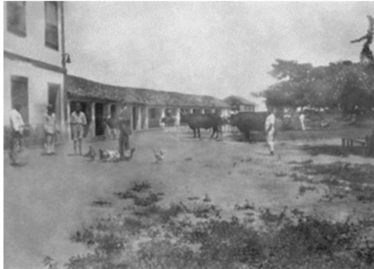
Figura 3.16 - Vista parcial das instalações e internos da Colônia Conde de Mesquita.
