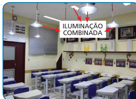
Foto 3 – Sistema de iluminação combinada
