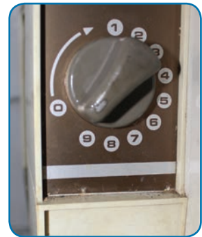
Foto 6 – Botão de regulação do termostato
