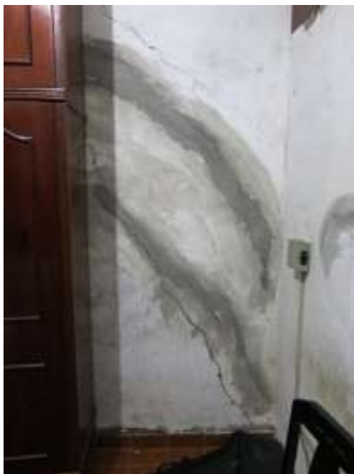
Figuras I.2.5 e I.2.7 – Rachaduras nas paredes do quarto do filho de D. Geralda. Março, 2016. Acervo: Projeto Arquitetando Intersubjetividades - Unisuam.
