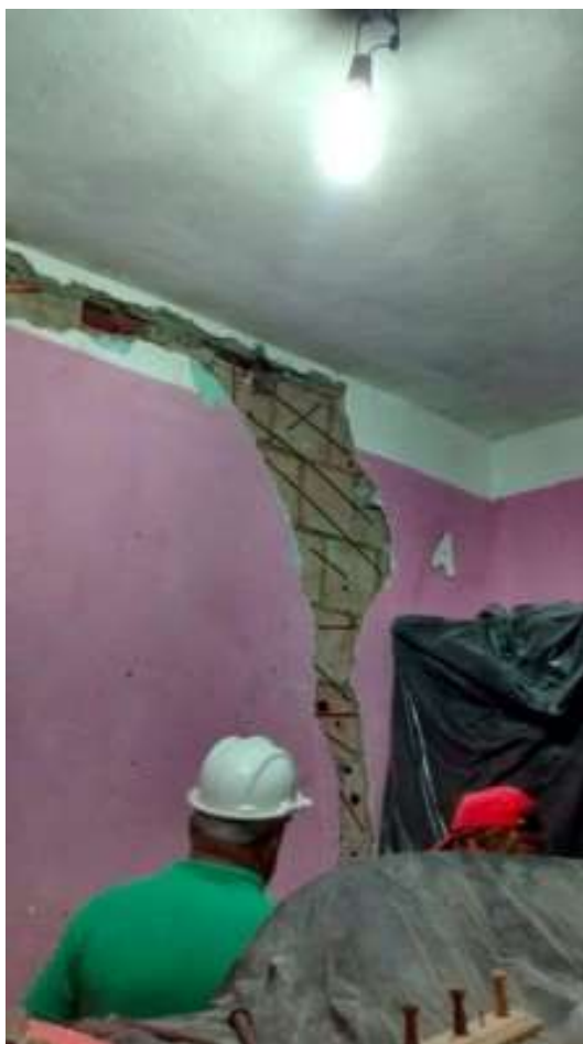
Figuras I.1.10 e I.1.11 - Funcionários da EMOP concluindo “reparos” nas rachaduras. Acervo: Projeto Arquetetando Intersubjetividades. 2015. Foto: Cedida por morador.
