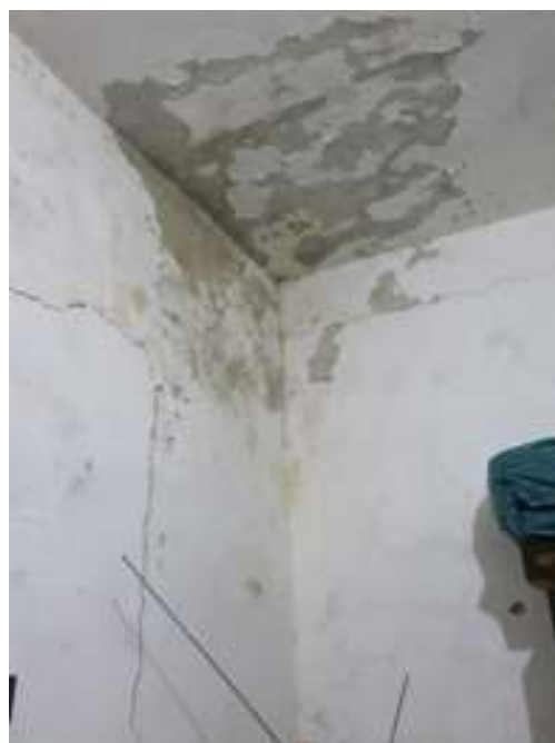
Figuras I.2.5 e I.2.7 – Rachaduras nas paredes do quarto do filho de D. Geralda. Março, 2016. Acervo: Projeto Arquitetando Intersubjetividades - Unisuam.
