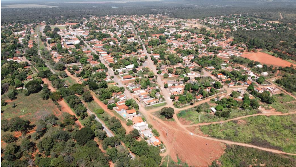
Figura 10: Imagem aérea de Lassance feita por drone.
