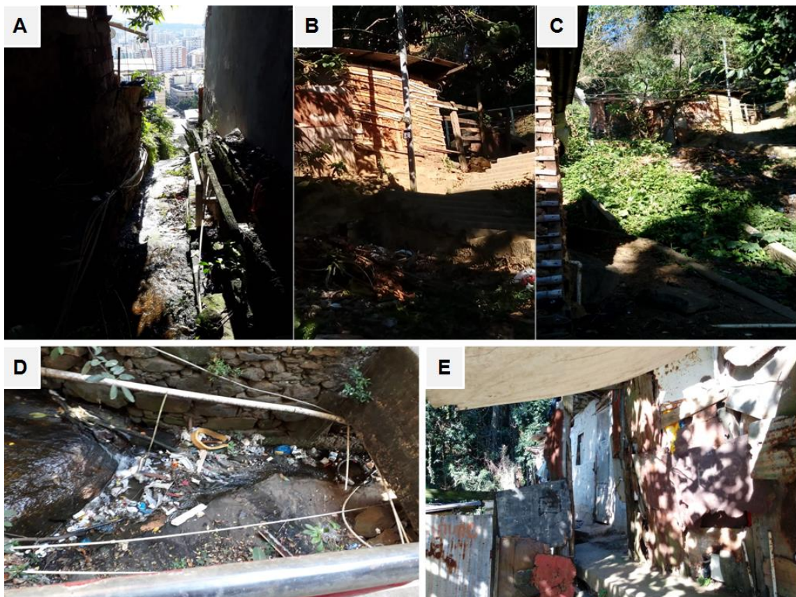
Figura 4. 3. Condições ambientais impróprias identificadas na Comunidade do Salgueiro, Rio de Janeiro, Brasil, 2018. a)valas onde são despejados esgoto dos domicílios, encanamento improvisado; b) habitação com paredes de pau a pique; c) moradias com construção precária, comunidade sem pavimentação; d) presença de lixo a céu aberto nas valas de escoamento de esgoto sanitário; e) domicílios improvisados com resto de materias de construção e lonas.
