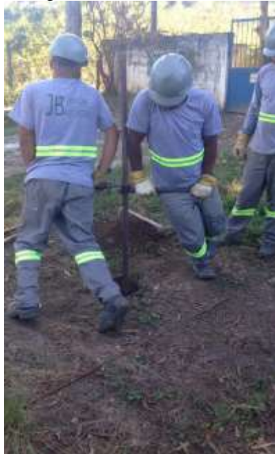
Figura 11: Sondagem com trado manual do tipo concha.
