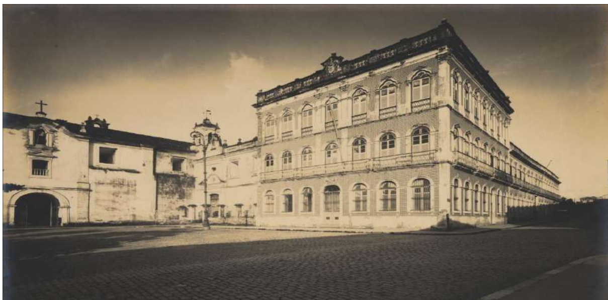
Figura 5: Hospital da Ordem Terceira. Belém
