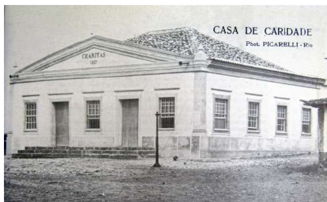
Figura 9: Edifício da antiga Casa de Caridade de Cabo Frio [1905]. Fonte: Acervo Wolney Teixeira.
