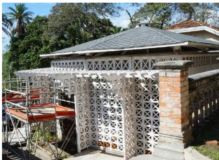
FIGURA 36 – Telhado com divisão clássica por águas e telhas planas asfálticas. Fonte: Autor, 2018.
