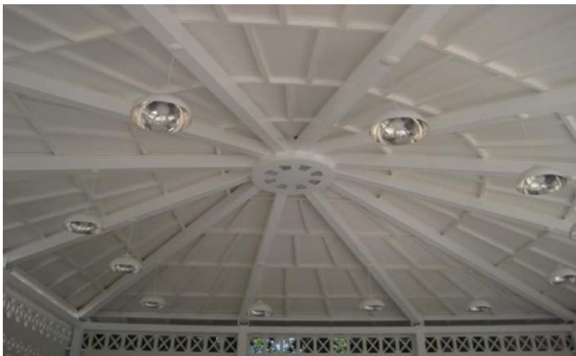
FIGURA 16 – Parte interna do telhado onde é possível ver as luminárias que atendem a edificação. Fonte: Arquivo DPH, 2010.
