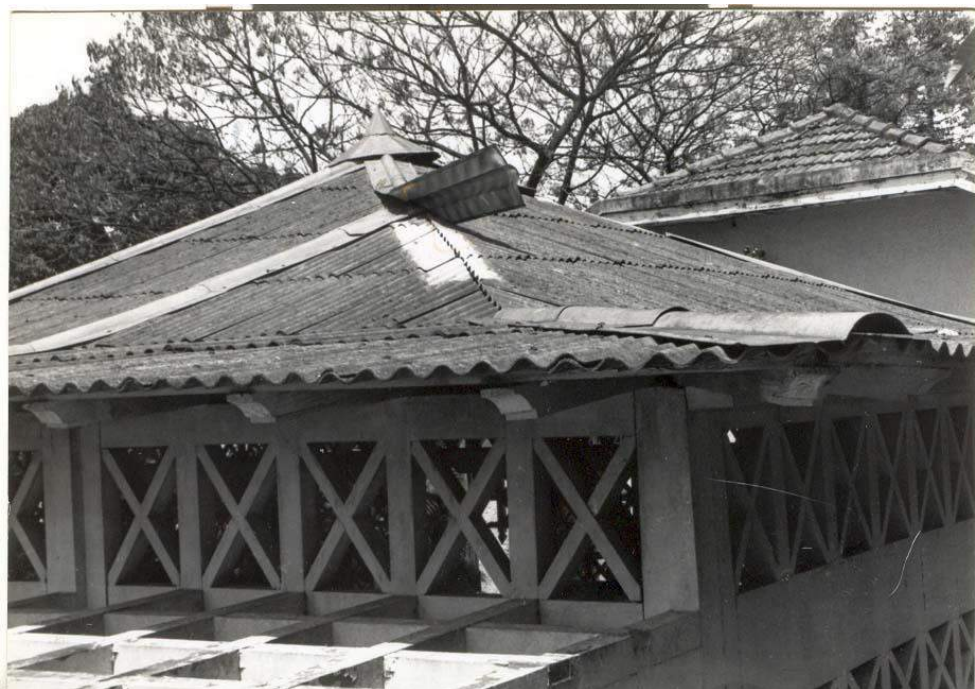
FIGURA 07 – Registro do telhado coberto com telhas de fibrocimento. Fonte: Acervo DAD/FIOCRUZ.
