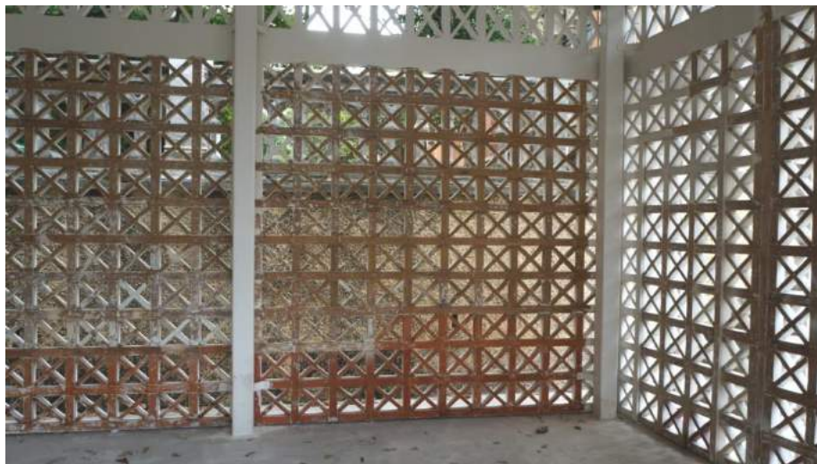
FIGURA 14 - Vista dos painéis que compõem a edificação, lixados ao máximo possível, com a finalidade de expor a madeira ao natural e já tratados com óleo de linhaça para combater o ataque xilófagos. Fonte: Autor, 2018.
