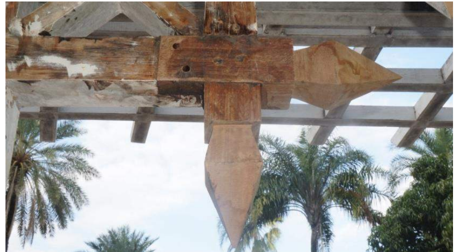
Figura 39– Recomposição do tipo Reposição - lacuna, tratada. Pináculo novo, fixado com sistema de encaixe cola e cavilha - Parte do processo de intervenção atual acompanhado pelo DPH Painel 02. Fonte: Autor 2019.
