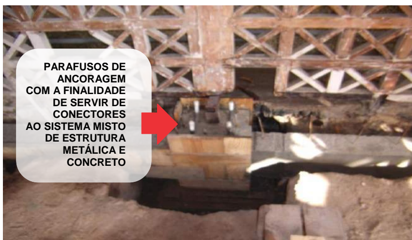
FIGURA 32 – Confeção das fundações onde é possível ver o cintamento, base de espera do pilar, com os parafusos de ancoragem já incorporados, fazendo o papel de conectores entre os dois sistemas construtivos (metálico e concreto armado). Fonte: Arquivo DPH, 2010.
