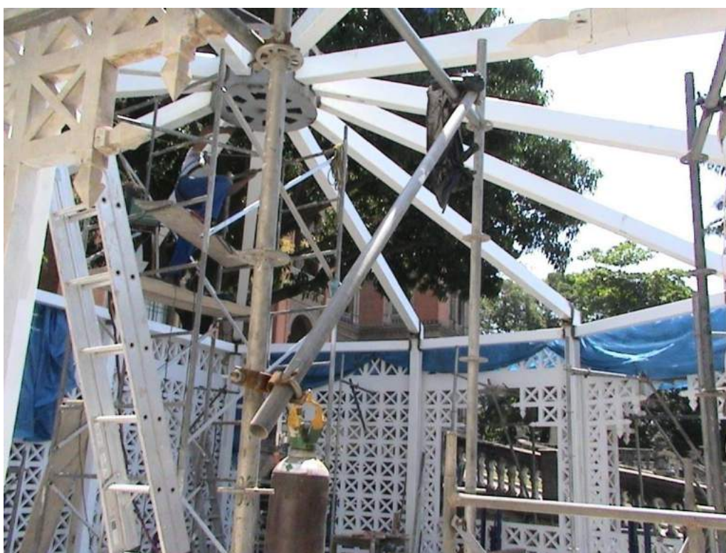
FIGURA 11 - Vista interna da montagem da estrutura metálica do telhado. Fonte: Acervo DPH/FIOCRUZ.
