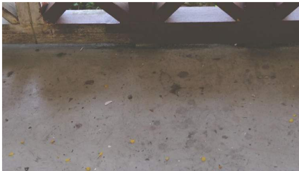
FIGURA 39 – Detalhe do piso, onde é possível ver que o mesmo é cimentício e polido. Fonte: Autor, 2018.
