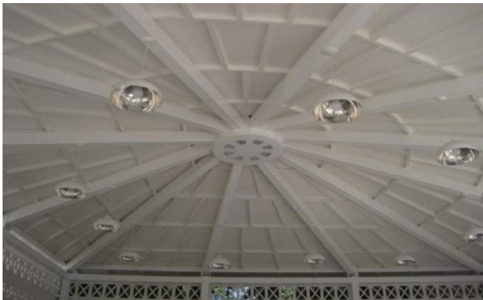
FIGURA 48 – Parte interna do telhado onde é possível ver as luminárias que atendem a edificação. Fonte: Arquivo DPH, 2010.
