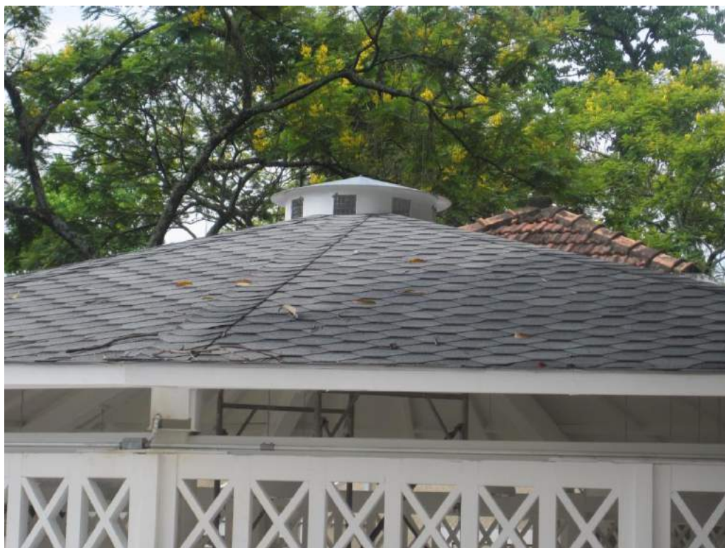
FIGURA 12 - Vista externa onde é possível ver parte do telhado recoberto com as telhas Shingles (confeccionadas em manta asfáltica). Fonte: Acervo DPH/FIOCRUZ.
