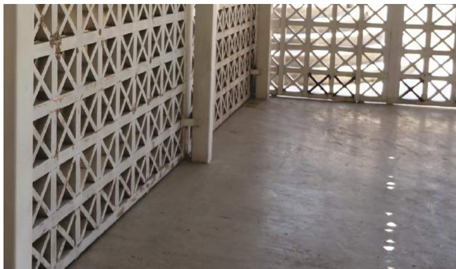
FIGURA 07 – Piso em concreto aparente, consolidado a estrutura de fundação. Fonte: Autor, 2018.
