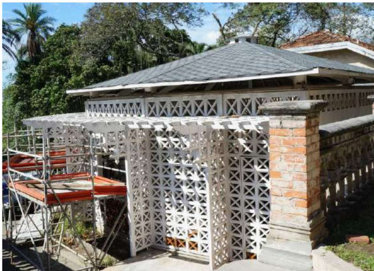
FIGURA 05 – Telhado com divisão clássica por águas e telhas planas asfálticas. Fonte: Autor, 2018.
