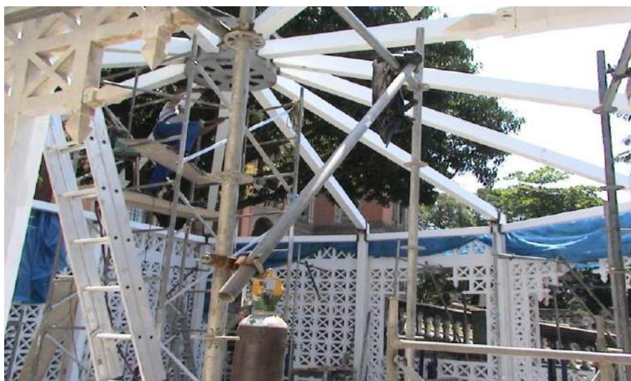
FIGURA 34 – Montagem da estrutura metálica, com fixação por solda. Fonte: Arquivo DPH, 2011.
