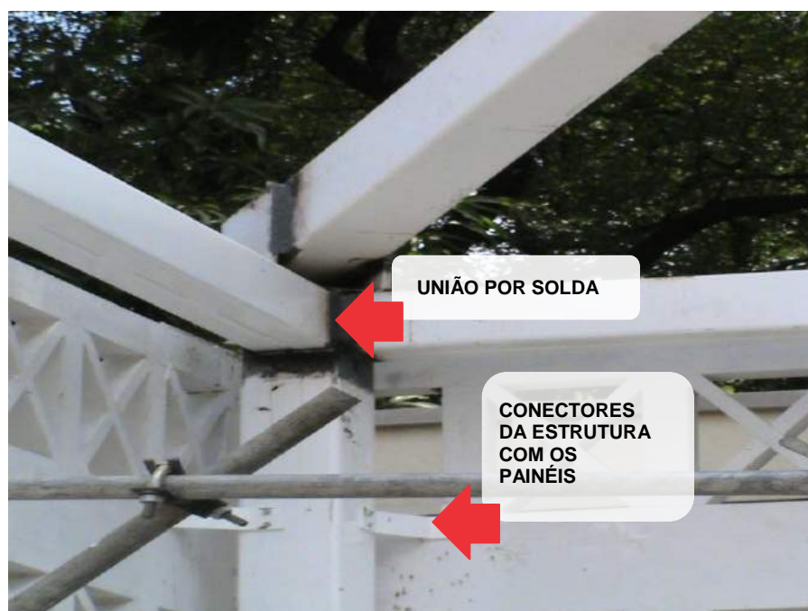
FIGURA 35 – Fixação por solda, e ancoragem aos painéis de madeira por parafusos. Fonte: Arquivo DPH, 2010.
