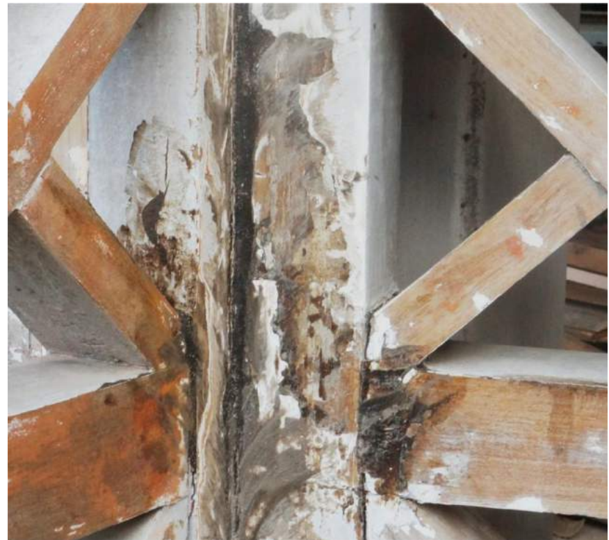
Figura 41– Recomposição do tipo Preenchimento – área de juntas-massa a base de serragem cola - Parte do processo de intervenção atual acompanhado pelo DPH - Painel 04. Fonte: Autor 2019.
