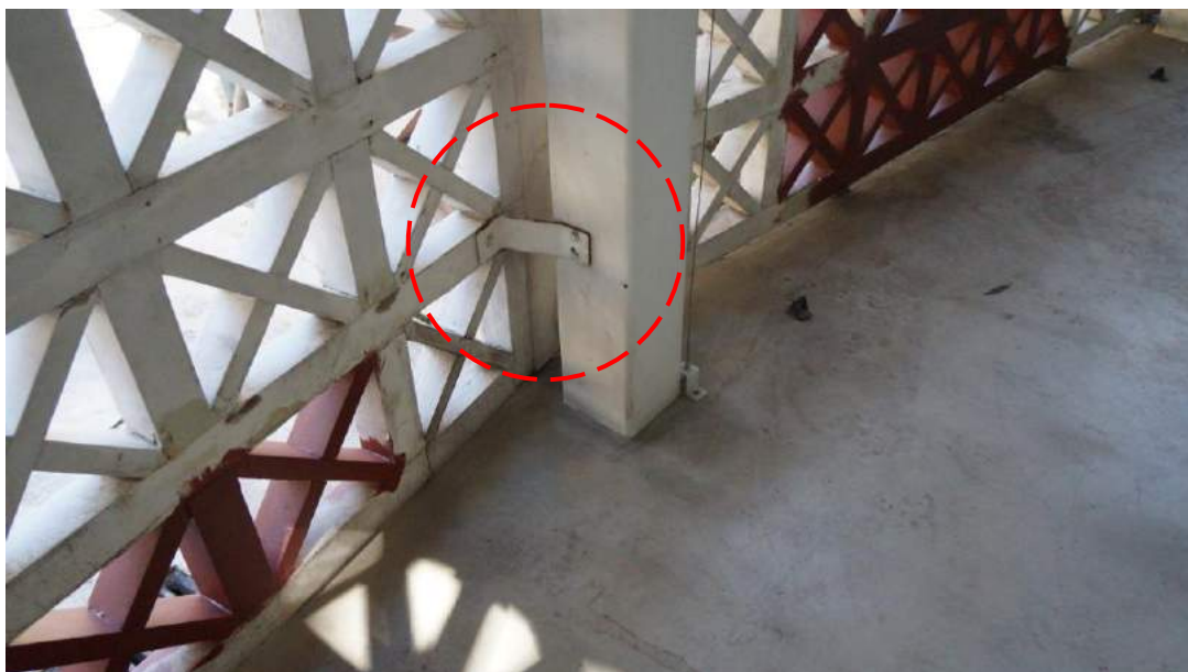
FIGURA 65 – Pilar entre os painéis 5 e 6, sem qualquer patologia aparente, fixado aos mesmos através de conectores (elementos de conexão). Aparelmente sólida sem qualquer sinal de mobilidade. Fonte: Autor, 2018.
