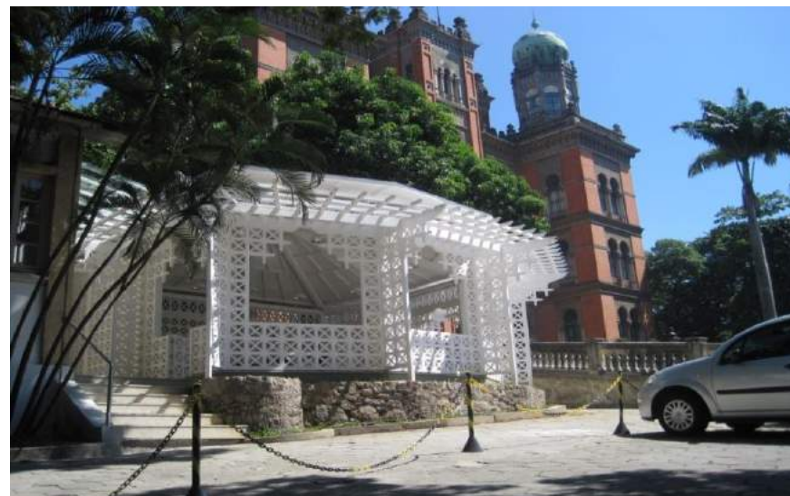
FIGURA 08 – Fechamento da caixa mural com os painéis treliçados. Fonte: Arquivo DPH, 2011.
