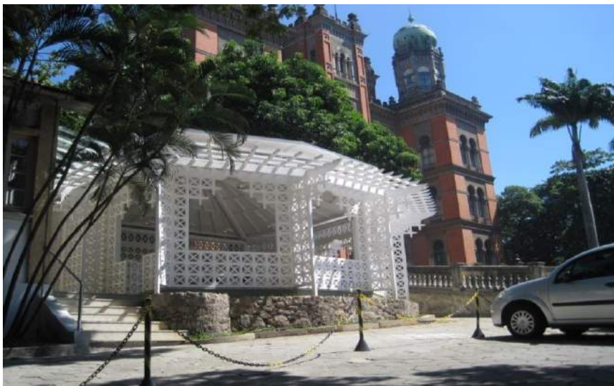
FIGURA 40 - Fechamento da caixa mural com os painéis treliçados Fonte: Arquivo DPH, 2011.
