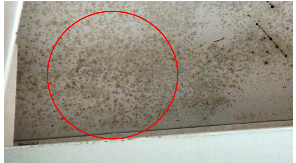
Figura 21 – Forro. Fonte: Autor 2018.
