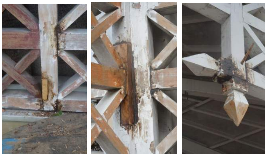
FIGURA 15 - Detalhes de peças recuperadas, com enxerto de madeira, ou fixação com cavilha. Fonte: Autor, 2019.
