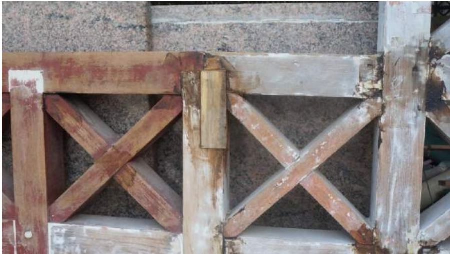
Figura 40– Recomposição do tipo Enxerto – área apodrecida, com troca parcial - Parte do processo de intervenção atual acompanhado pelo DPH - Painel 02. Fonte: Autor 2019.
