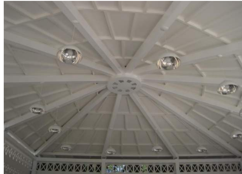
FIGURA 06 – Parte interna da estrutura mista (madeira e metal) com acabamento em esmalte sintético. Fonte: Arquivo DPH, 2011.
