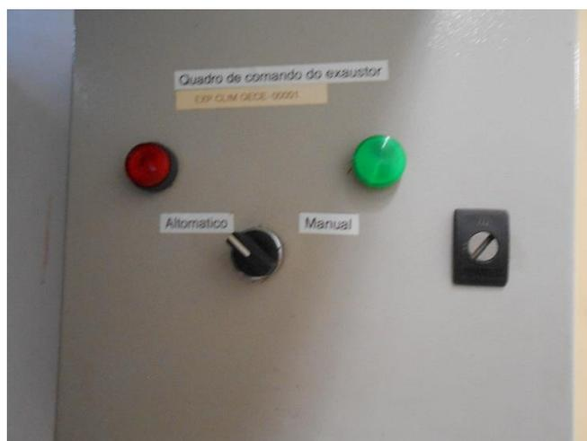
Figura 28. Sala de identificação, limpeza e diagnóstico. Esta sala está equipada com um sistema automático de exaustão, com a opção de ser acionado manualmente. Este procedimento visa liberar o ambiente dos gases exalados pelas películas em seu processo de deterioração. Foto: Juçara Palmeira
