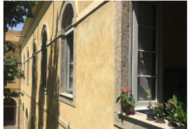
Figura 60. Fachada do Pátio interno Fonte: Arquivo pessoal
