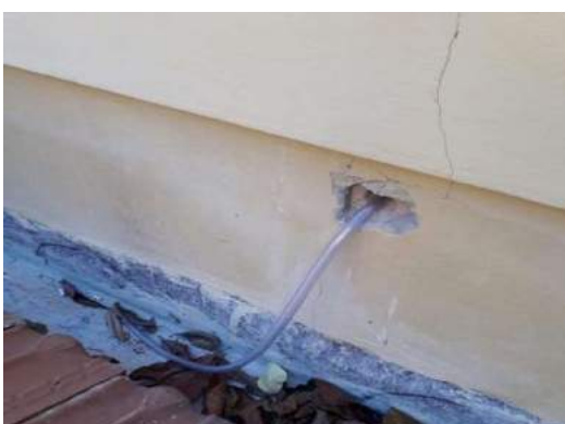
Figura 108. Intervenções para passagem de mangueira de ar condicionado em fachadas. Fonte: Arquivo Pessoal
