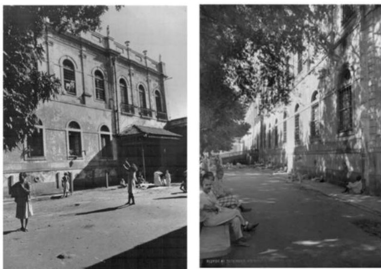
Figura 25. Fachada leste (ala feminina), patio 6. Fonte: IPHAN Figura 26: Fachada oeste (ala masculina), patio 6. Fonte: IPHAN
