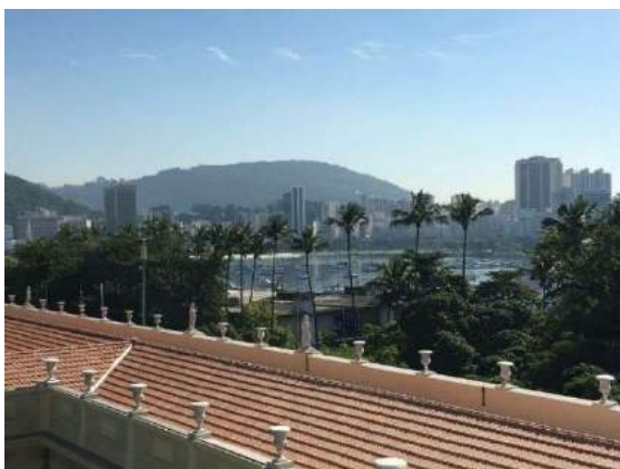
Figura 55. Cobertura em telhas francesas. Fonte: Arquivo pessoal
