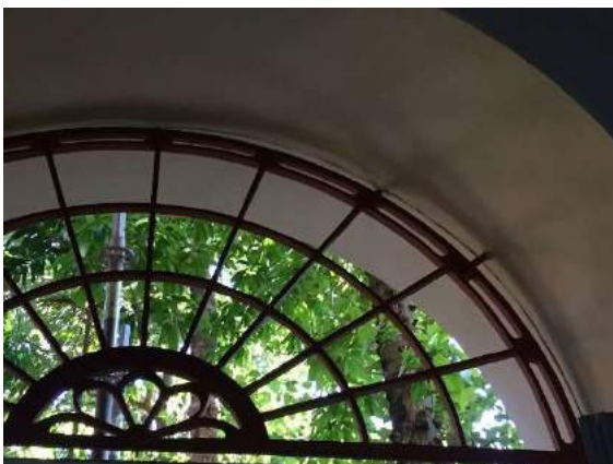
Figura 67. Arcos dos pórticos nos pátios internos. Fonte: Arquivo pessoal
