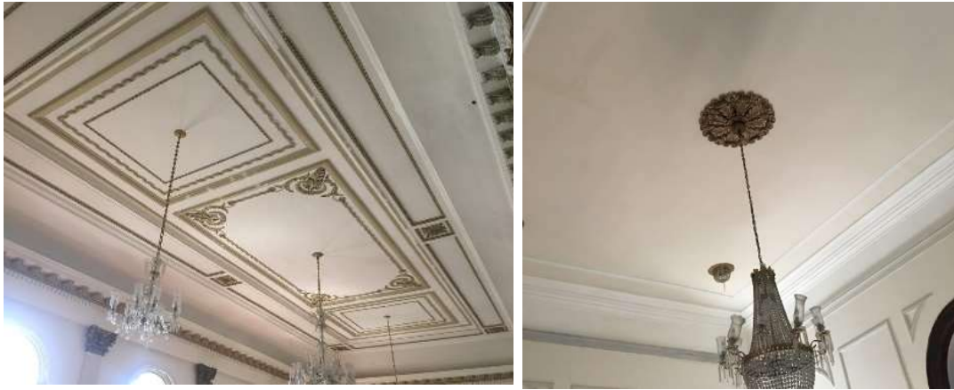
Figura 95. Forros em gesso, Salão Dourado e Sala do gabinete. Fonte: ETU/ UFRJ.
