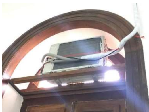
Figura 106. Intervenções para instalação de ar condicionado em janelas. Fonte: Arquivo Pessoal
