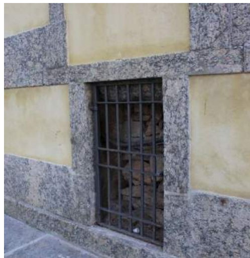
Figura 66. Tubulações de águas pluviais e portões dos porões em ferro fundido. Fonte: Arquivo pessoal
