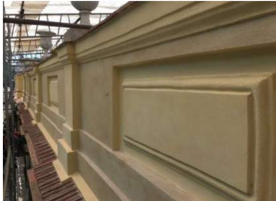
Figura 59. Platibandas Fonte: Arquivo pessoal
