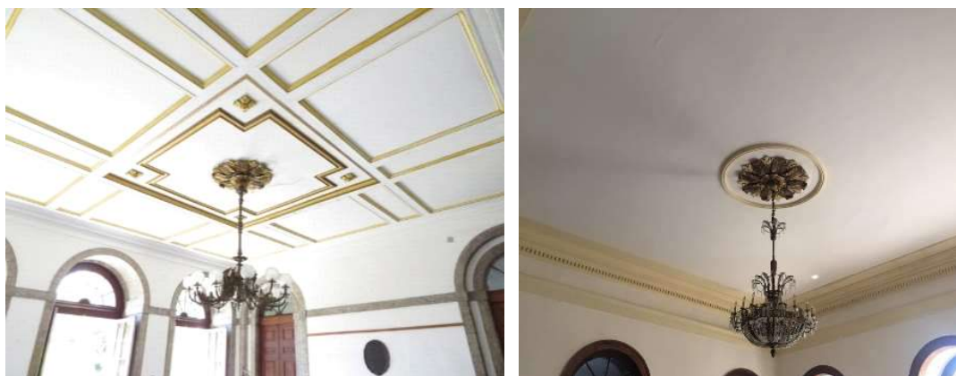
Figura 92 e 93. Forros em gesso, Hall e Salão Vermelho. Fonte: ETU/ UFRJ.
