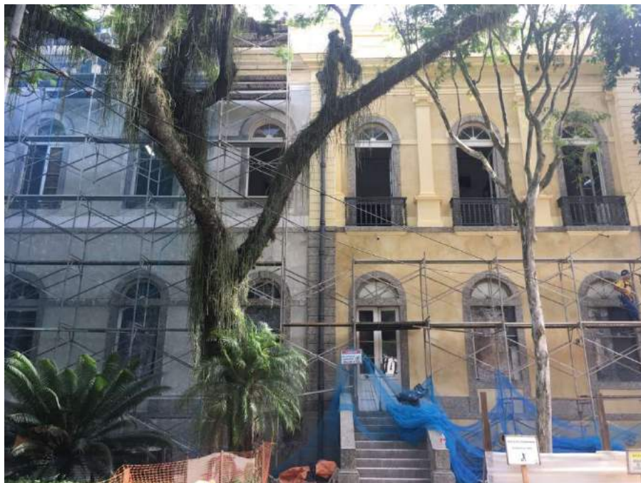
Figura 138. Fachada sul, antes e depois da restauração. Fonte: Arquivo pessoal.
