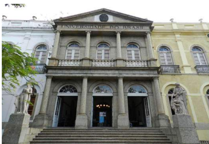
Figura 132. Fachada principal do Palácio Universitário, antes e depois da restauração. Fonte: Arquivo pessoal.
