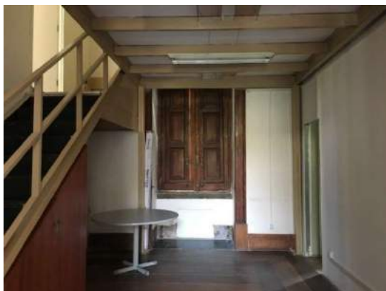
Figura 104. Ambientes de um pavimento com acréscimo de um segundo pavimento com construção de mezanino em estrutura metálica. Fonte: Arquivo Pessoal
