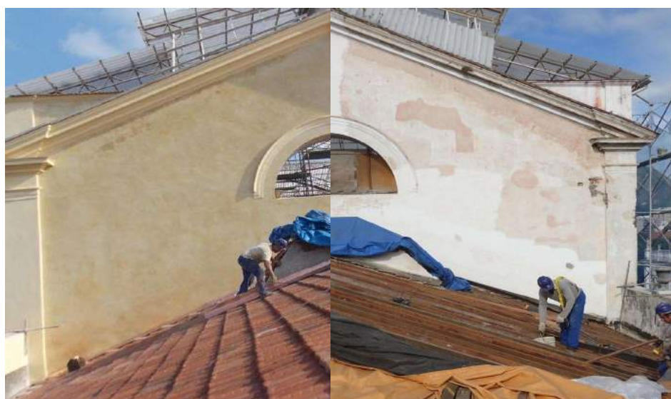
Figura 136. Capela, depois e antes da restauração Fonte: Arquivo pessoal.
