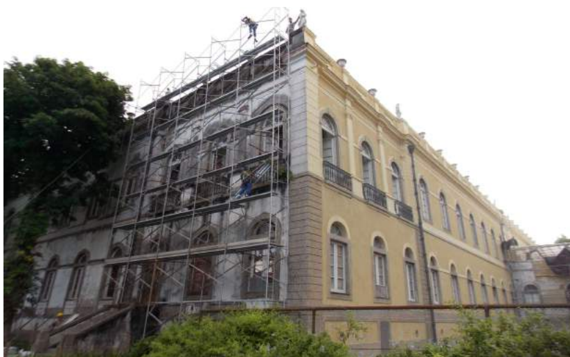
Figura 133. Fachada Sul e Fachada da piscina, antes e depois da restauração. Fonte: Arquivo pessoal.
