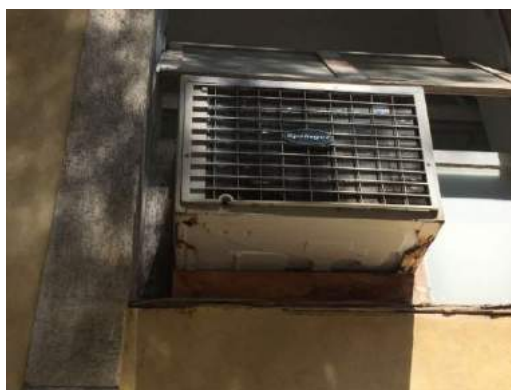
Figura 107. Intervenções para instalação de ar condicionado em janelas. Fonte: Arquivo Pessoal
