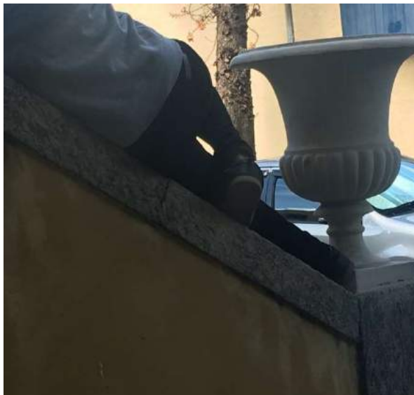
Figura 114. Exemplo de mau uso da edificação. Fonte: Arquivo pessoal.
