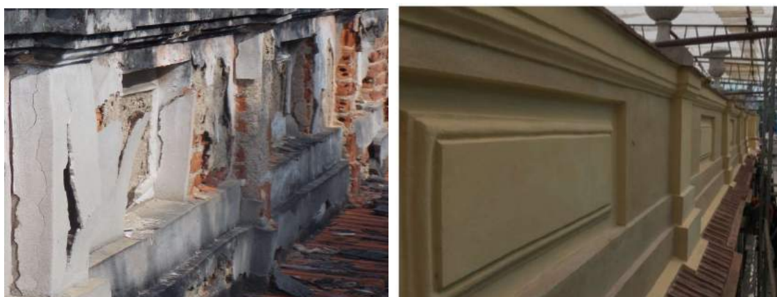
Figura 134 e 135. Platibanda, antes e depois da restauração Fonte: Arquivo pessoal.
