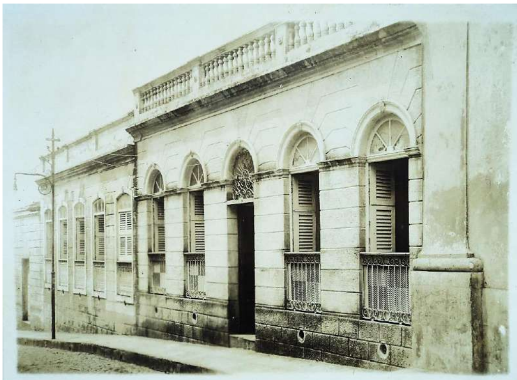
Fotografia 37. Fachada dos dois prédios que sediavam a filial do Instituto Oswaldo Cruz no Maranhão Fonte: MIRANDA, 1923a, p.1
