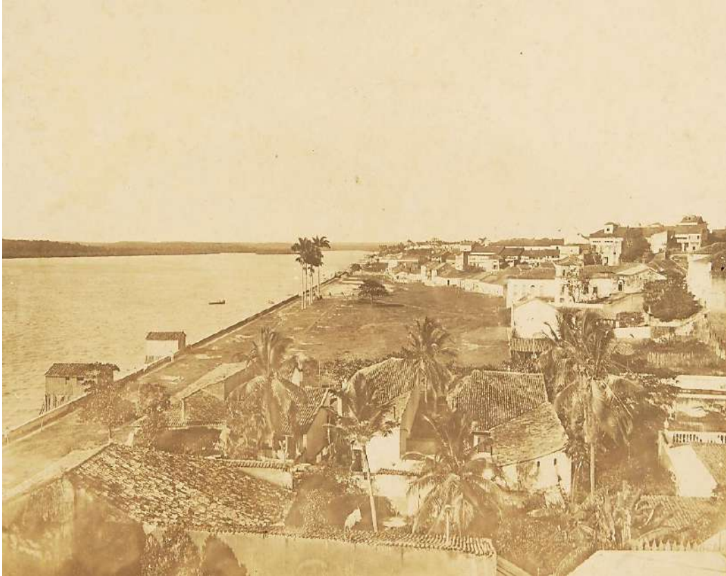
Fotografia 3. Baluarte e margens do rio Anil – São Luís (Legenda original) Fonte: CUNHA, 1908
