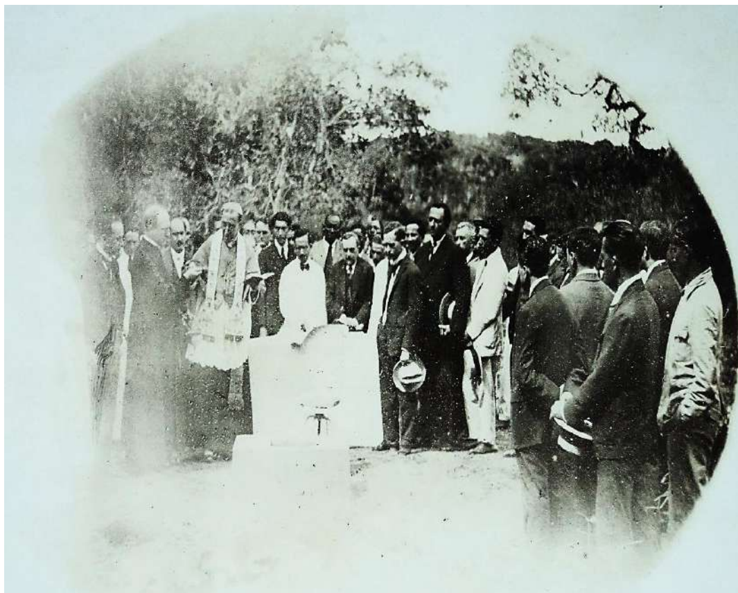
Fotografia 51. Benção da pedra fundamental das novas instalações da filial (Legenda original) Fonte: MIRANDA (1923a, p.35)
