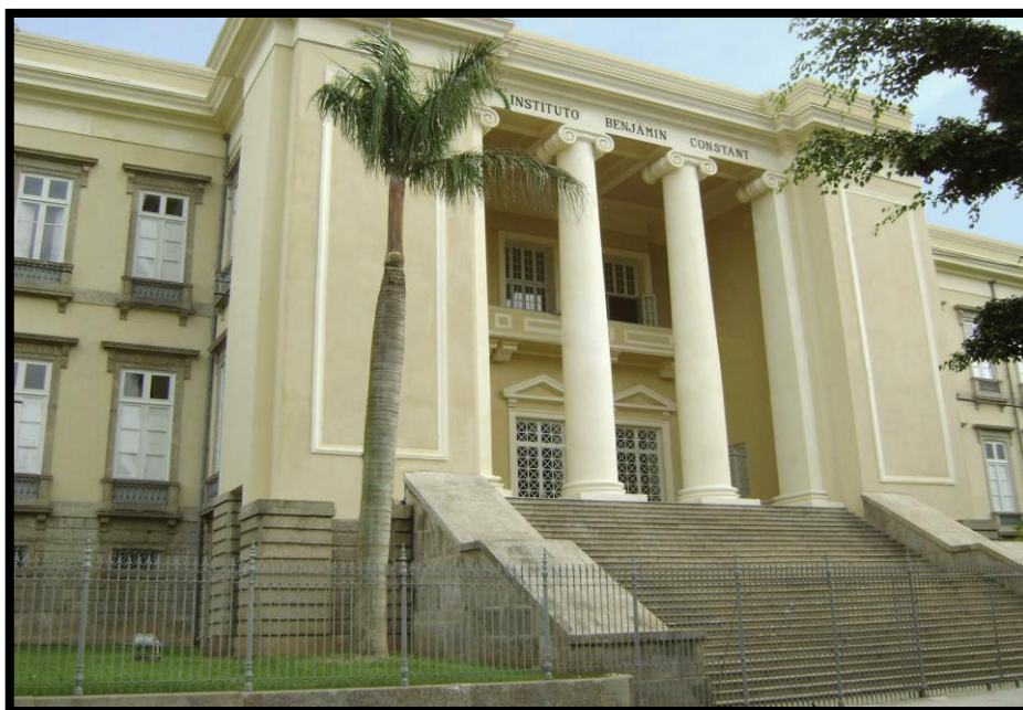
Figura 10: Fachada principal do IBC
