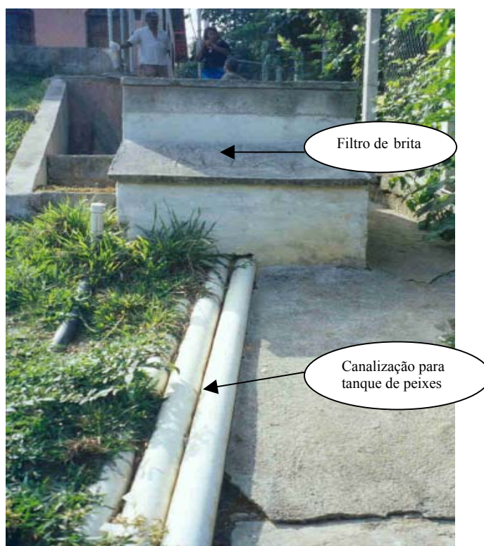
FOTO 3 – Filtro biológico anaeróbico de três câmaras
