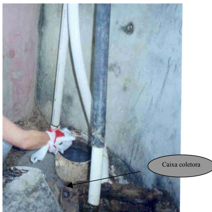
FOTO 5 caixa para coleta da água cinza proveniente de chuveiros e pias de banheiros.
