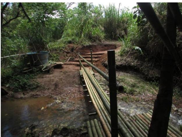
**Figura 6:** Ponte de bambu (depois do córrego). Fonte: Arquivo pessoal
