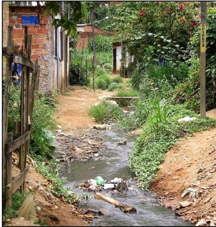
FIGURA 1: Foto ilustrativa da favela Pau da Lima, mostrando as condições precárias de habitação e saneamento básico.
