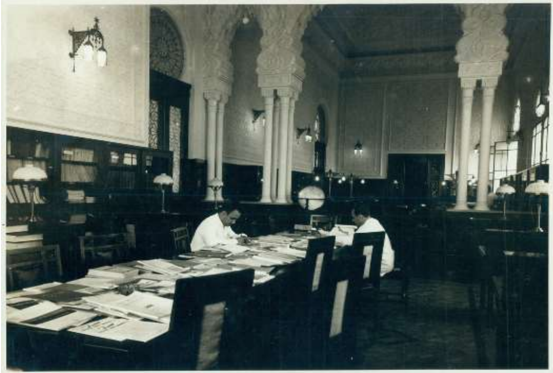
Figura 6 - Salão de leitura da Biblioteca de Manguinhos, 1950/1960
