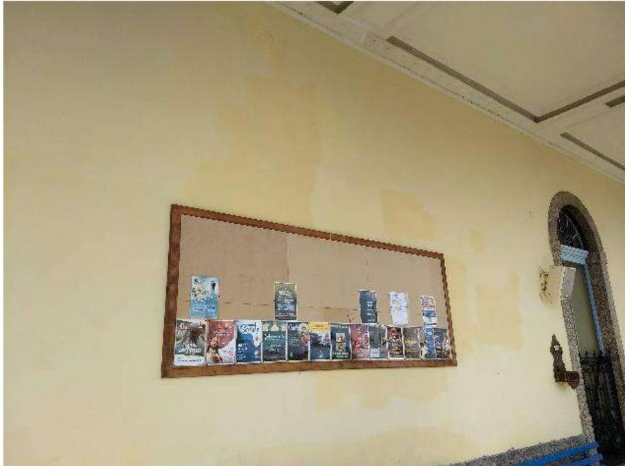
Figura 114 - Manchas na pintura por aplicação incorreta de tinta.
