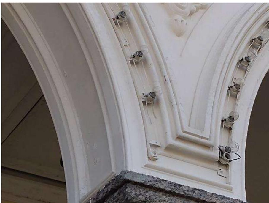
Figura 117 - Descolamento de pintura nos arcos das galerias externas.
