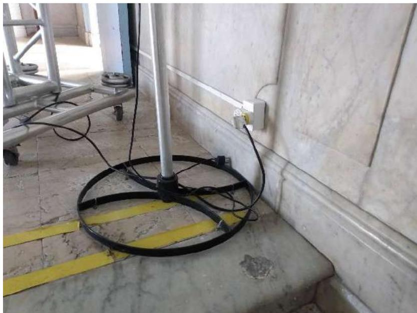
Figura 143 - Instalações elétricas irregulares.
