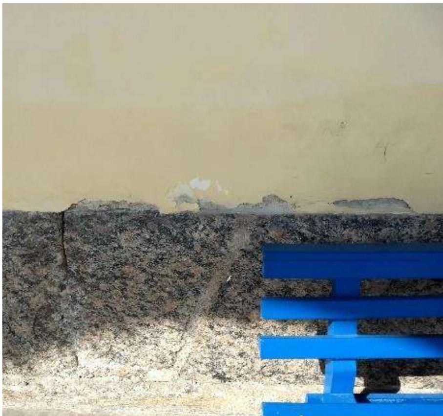
Figura 116 - Perda de material do reboco.
