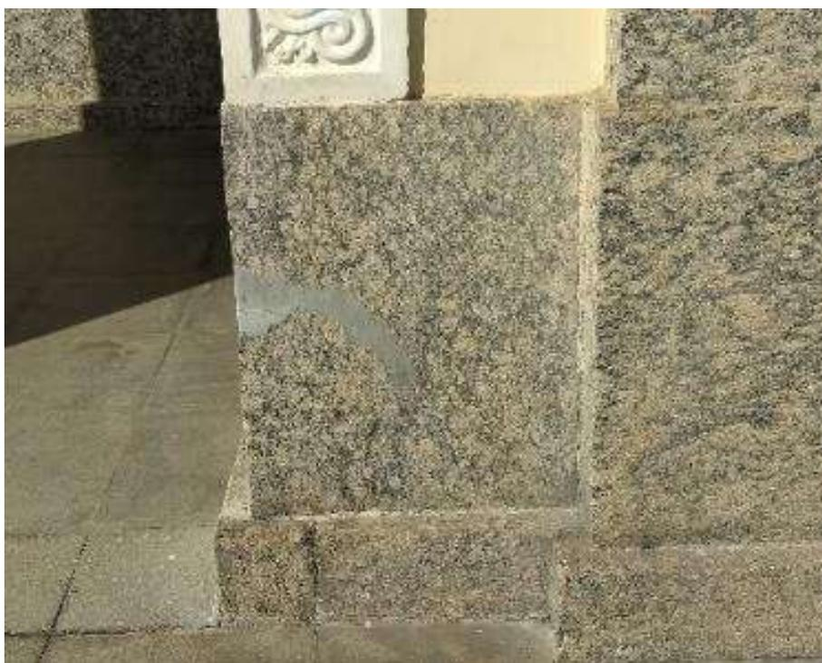
Figura 128 - Preenchimento com material incompatível (direita).
