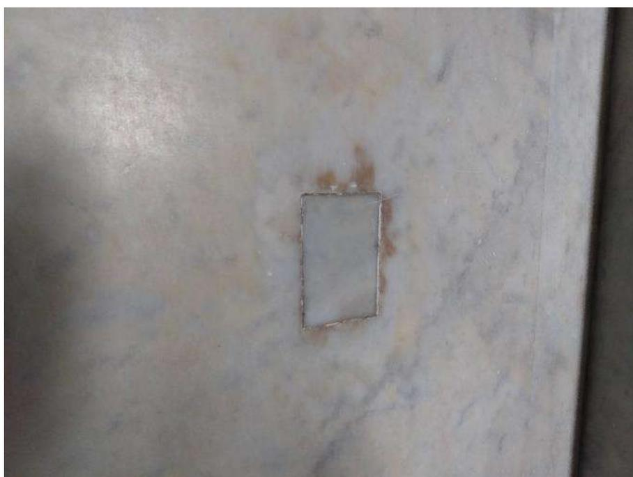
Figura 144 - Preenchimento com material compatível.
