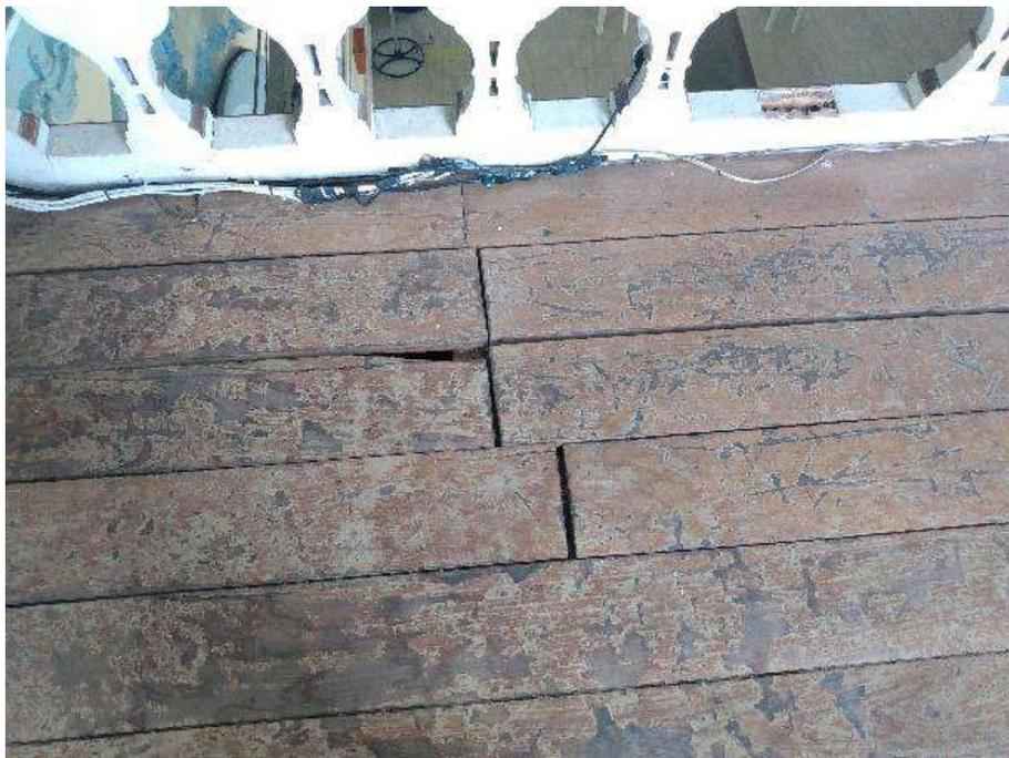
Figura 106 - Assoalho solto, com partes faltantes e perda de camada protetiva.
