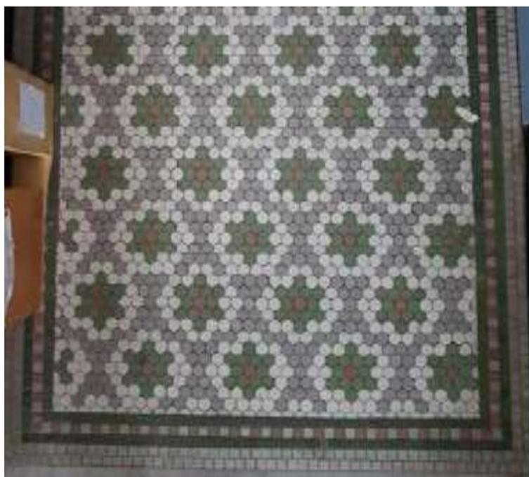
Figura 87 - Pastilhas hexagonais na circulação lateral, próximas ao presbitério.
