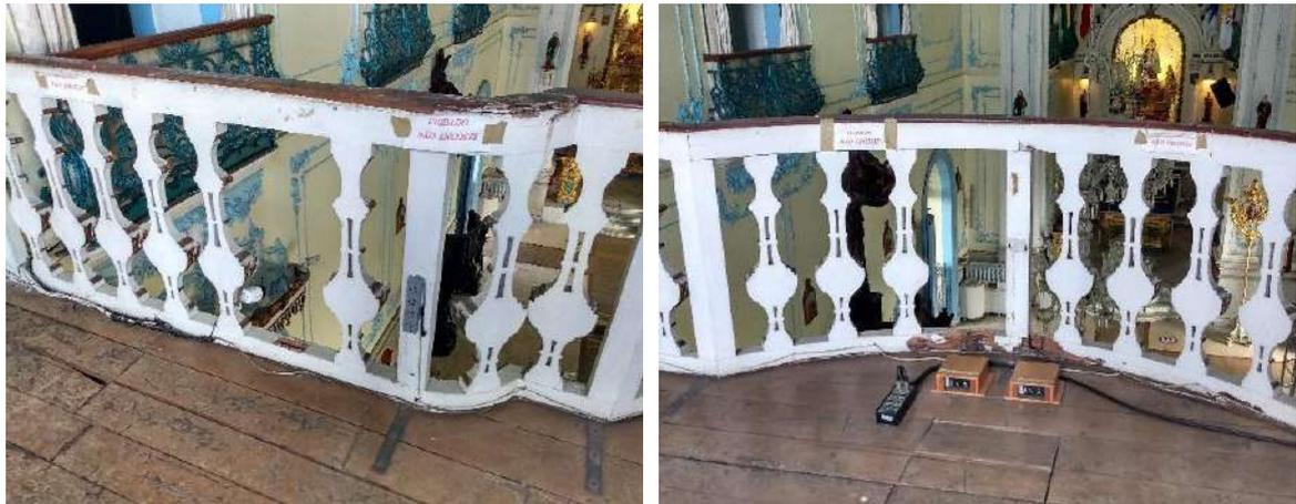
Figura 105 - Perda de elementos e instalações elétricas irregulares.
