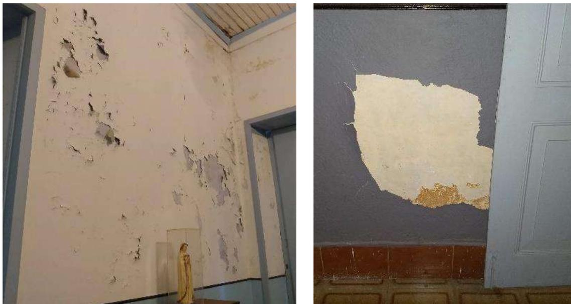
Figura 157 - Descolamento de pintura, pavimento superior.
