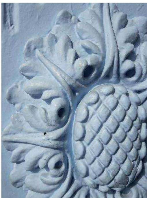
Figura 175 - Excessivas de camadas de pintura.
