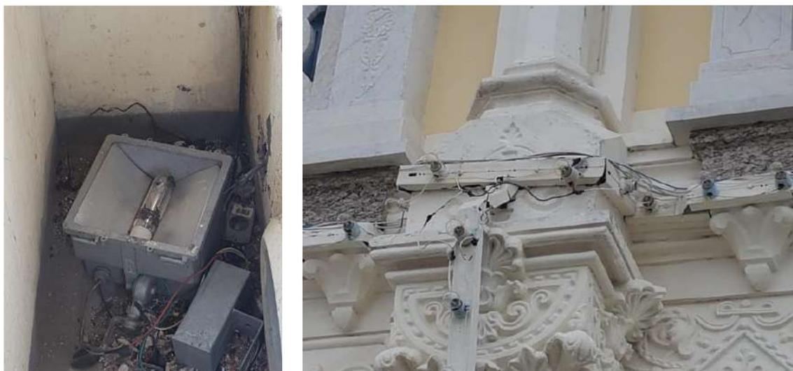
Figura 205 - Instalações elétricas irregulares.
