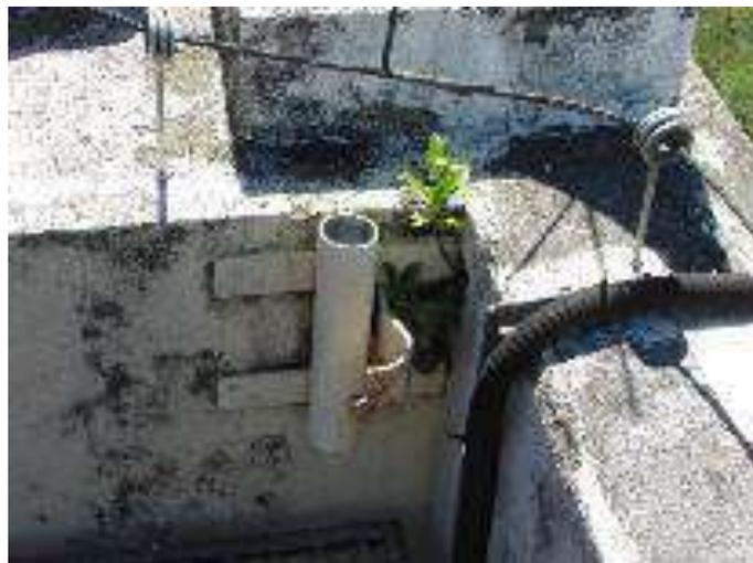
Figura 110 - Macha negra, umidade e presença de vegetação.
