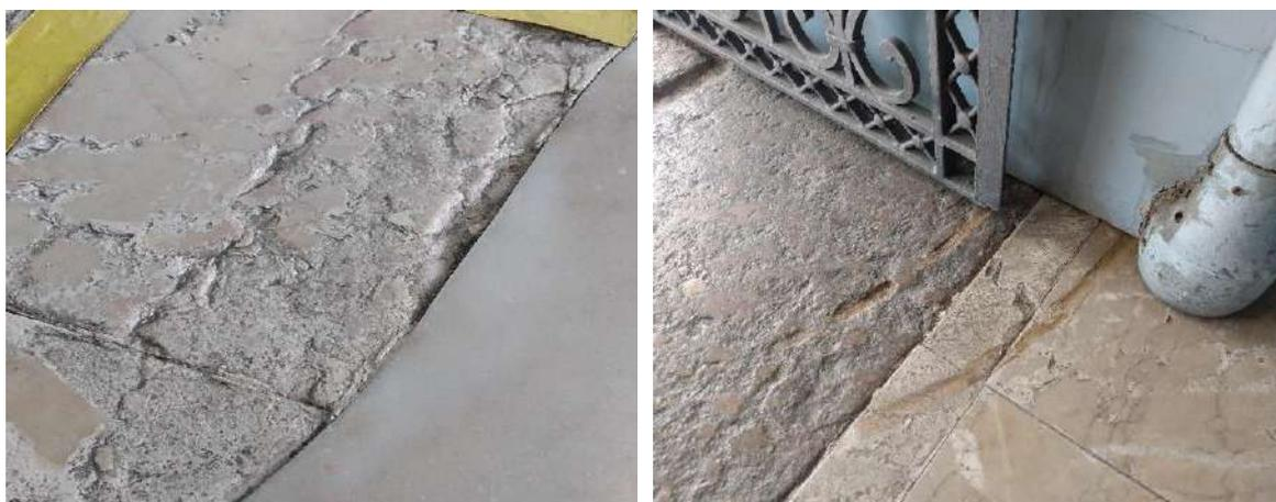
Figura 148 - Desgaste por uso contínuo.
