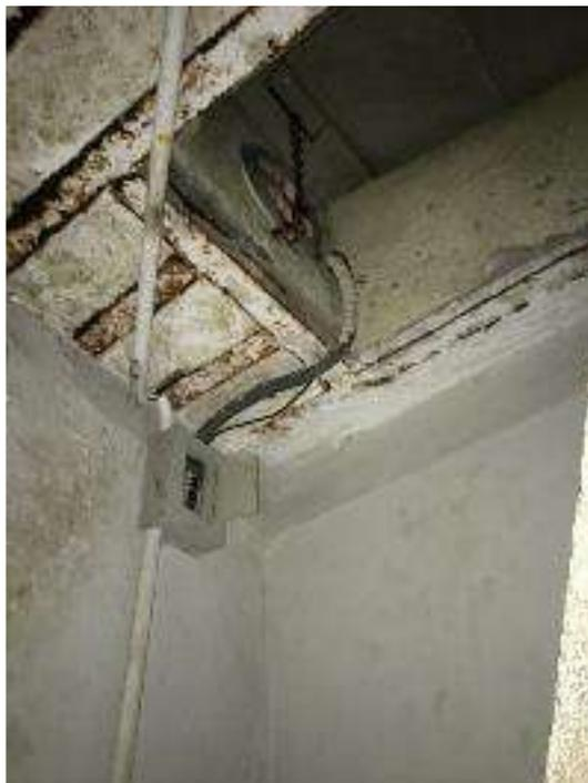
Figura 103 - Marcas de ferrugem da laje do nível dos sinos.
