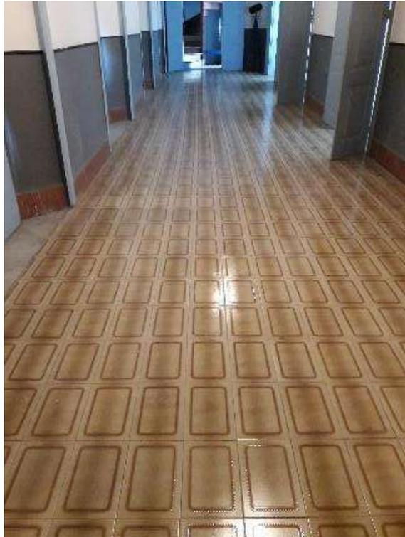
Figura 170 - Piso cerâmico substituindo o piso anterior em madeira.
