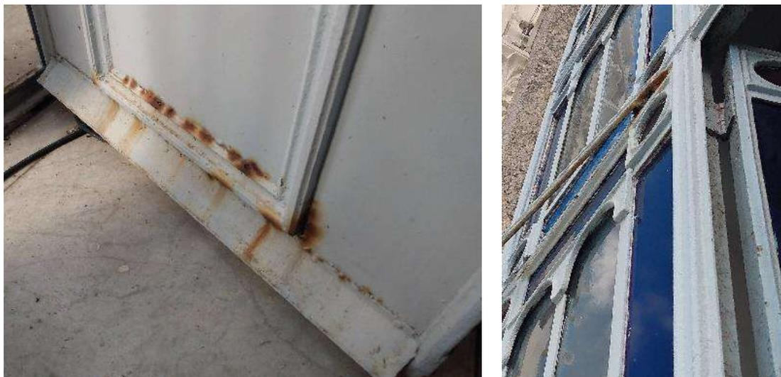
Figura 181 - Marcas de ferrugem e vidro quebrado na porta de acesso à sacada.
