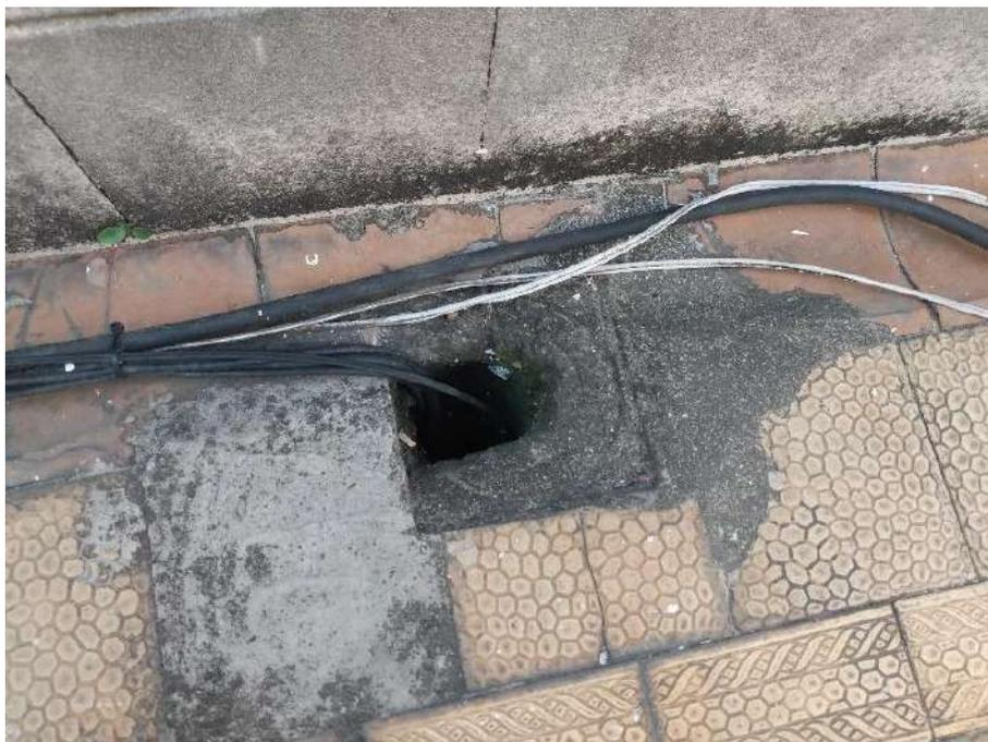
Figura 204 - Instalações elétricas passando por tubulação de águas pluviais.
