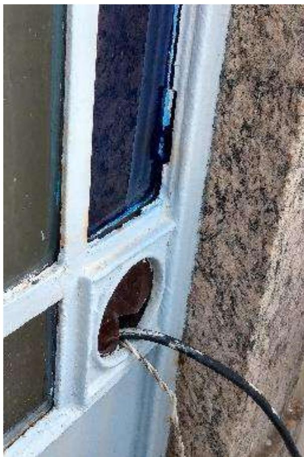
Figura 182 - Marcas de ferrugem e vidro quebrado na porta de acesso à sacada.
