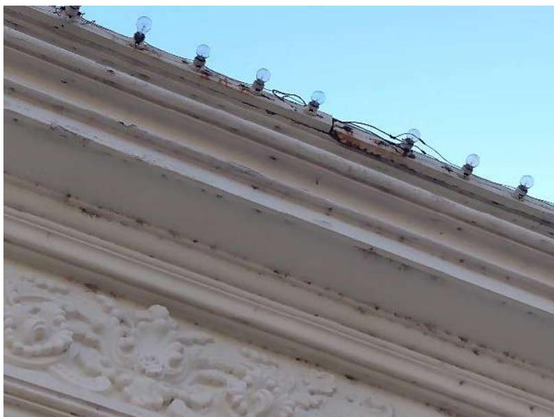
Figura 124 - Ferrugem proveniente da estrutura de fixação da iluminação de silhueta.
