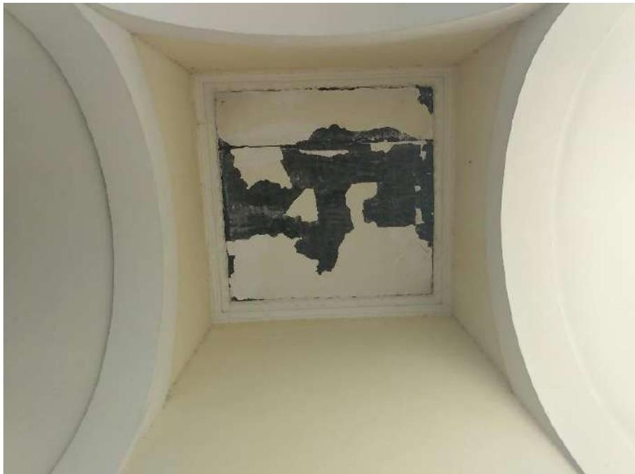
Figura 121 - Descolamento de pintura sob o forro da torre sineira Olaria, proveniente da ação da água da chuva.
