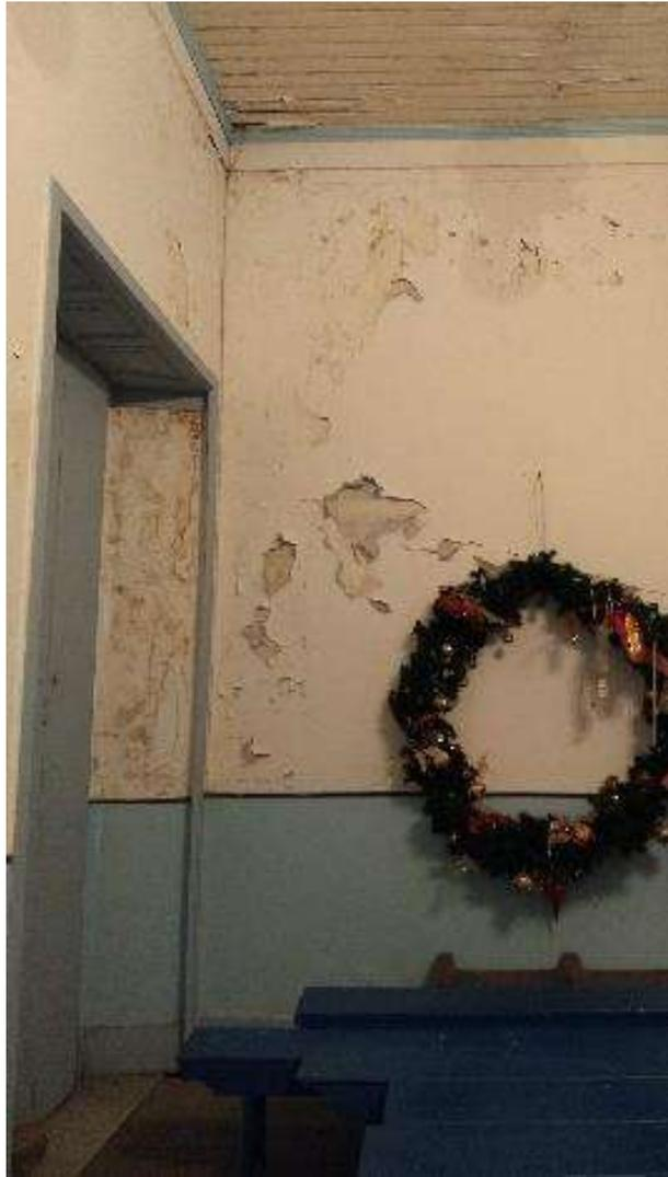
Figura 159 - Machas de umidade e descolamento de pintura no pavimento superior.
