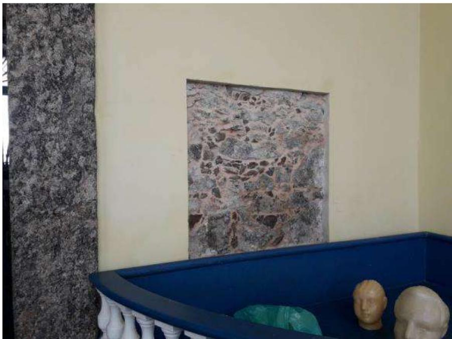
Figura 70 - Alvenaria autoportante em pedra argamassada.
