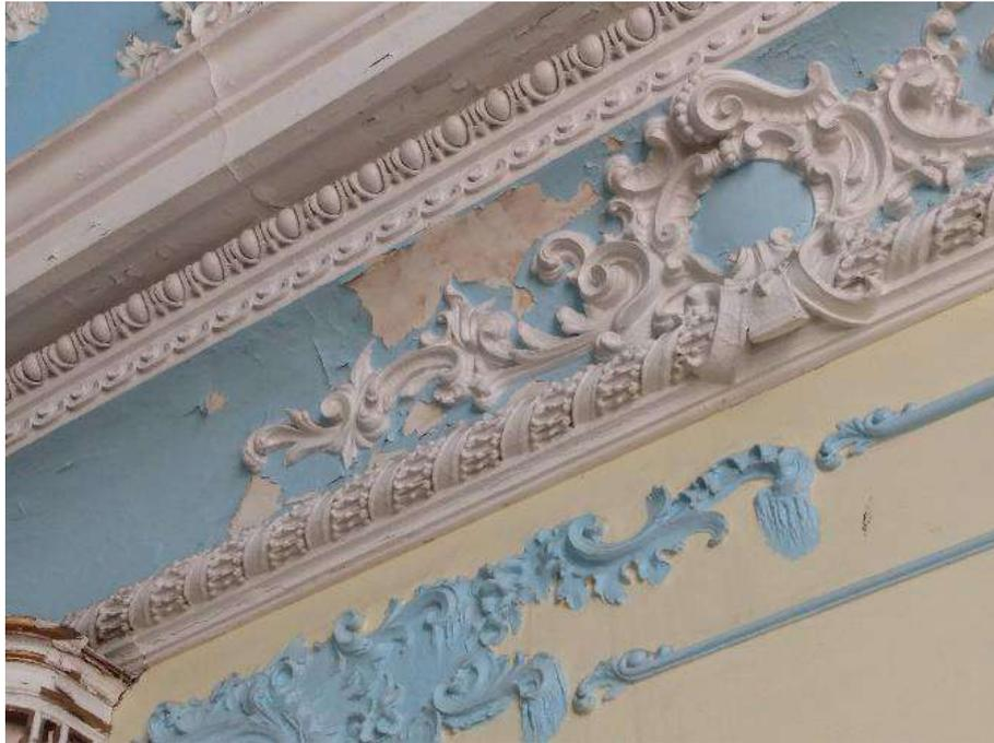
Figura 133 - Manchas de umidade, descolamento de pintura.
