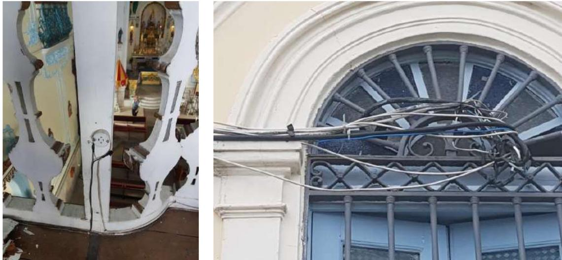
Figura 206 - Instalações elétricas irregulares.
