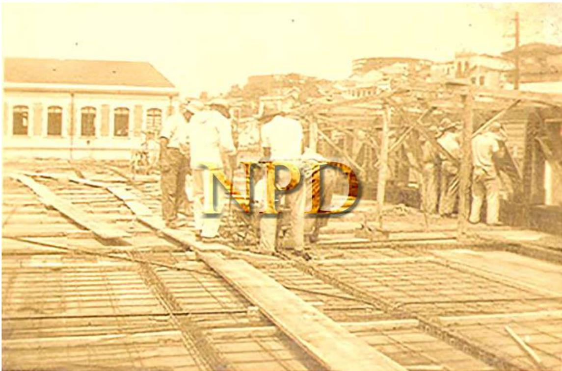
Figura 1 - Concretagem das vigas e lajes do Albergue época da construção em 1930.
