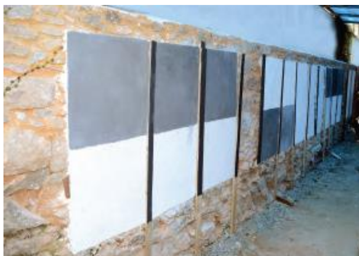
Figura 19 – Vista geral da parede-teste
