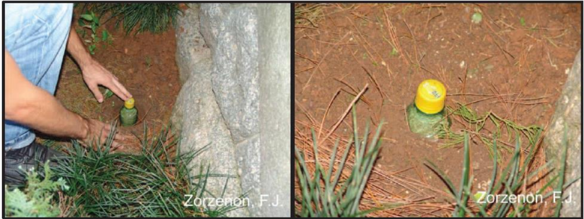
Figura 29 - Instalação das iscas para monitoramento e erradicação dos cupins. Fonte: (MENON, 2010)
