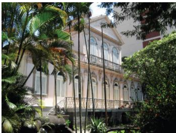
Figura 16 – Fachada principal Museu Casa de Rui Barbosa, dezembro 2011
