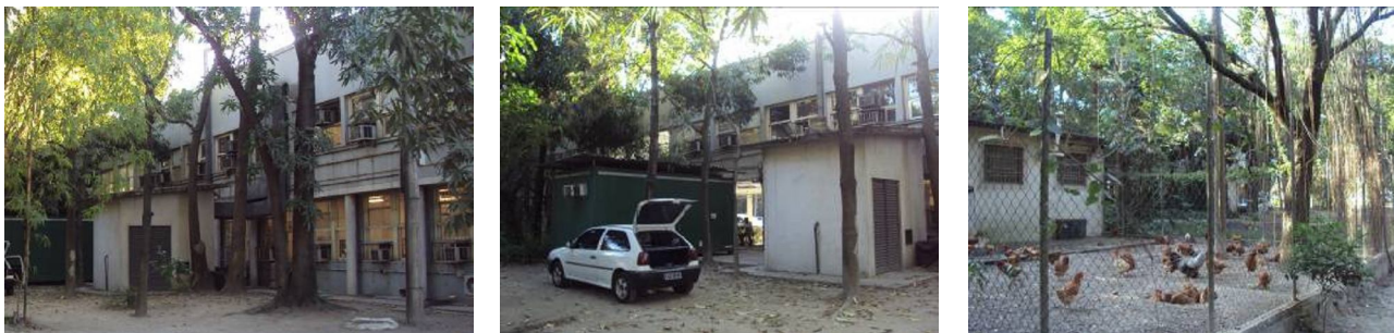
Edículas e construções de caráter provisório que interferem na ambiência do Pavilhão Arthur Neiva.
