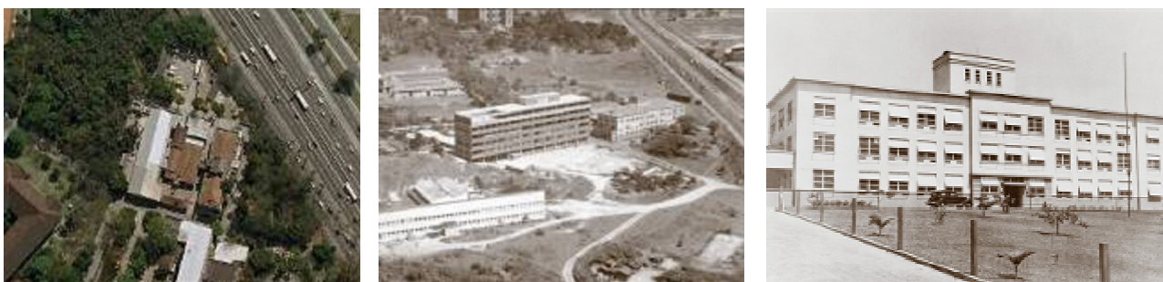
Figuras 22 a 24. Conjunto Rockefeller: situação atual (Google) e foto histórica (s/d) com o prédio no alto à direita. Início do processo de arborização do campus. À direita, o Pavilhão Rockefeller logo após a construção. A proposta de abertura de nova portaria de acesso para pedestres ao campus, na avenida Brasil, provavelmente irá conferir um novo protagonismo ao edifício e sua fachada principal.
