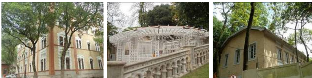
Figuras 06 a 08. Quinino, Casa de Chá e Restaurante. Em 1986, foi iniciado no IPHAN o Processo nº 40099.060054/86-41, com proposta de extensão de tombamento incluindo as demais edificações construídas no período eclético, essas incluídas. O processo ainda não foi efetivado.
