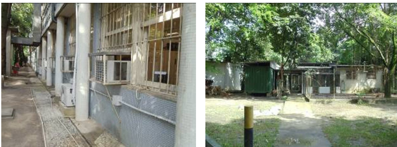
Figuras 49 e 50. Usos e descaracterizações na Área de Preservação: Pavilhão Arthur Neiva.
