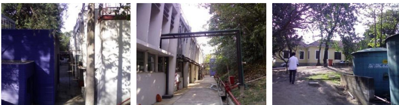
Instalações e equipamentos de infraestrutura próximos ao Pavilhão Henrique Aragão.
