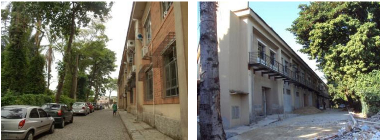
Intervenção recente feita no Pavilhão Cardoso Fontes.
